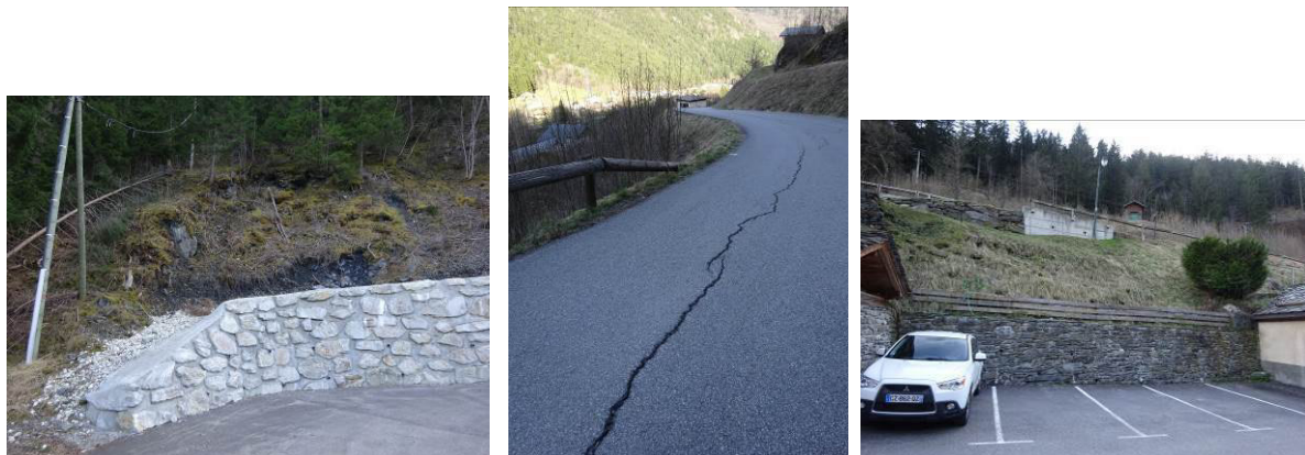
A gauche : reprise du mur de soutènement de la route d'accès à Ronaz après son basculement sur 10 m de long. Au centre : fissures d'affaissement de la route d'accès à la Bonneville. A droite : murs de soutènement successifs dans l'axe de la combe en glissement moyen, jusqu'au parking de la Bonneville.
