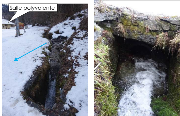
A gauche : zone de débordement probable juste en amont de la RD 84b. A droite : ouvrage de franchissement de la RD 84b.
