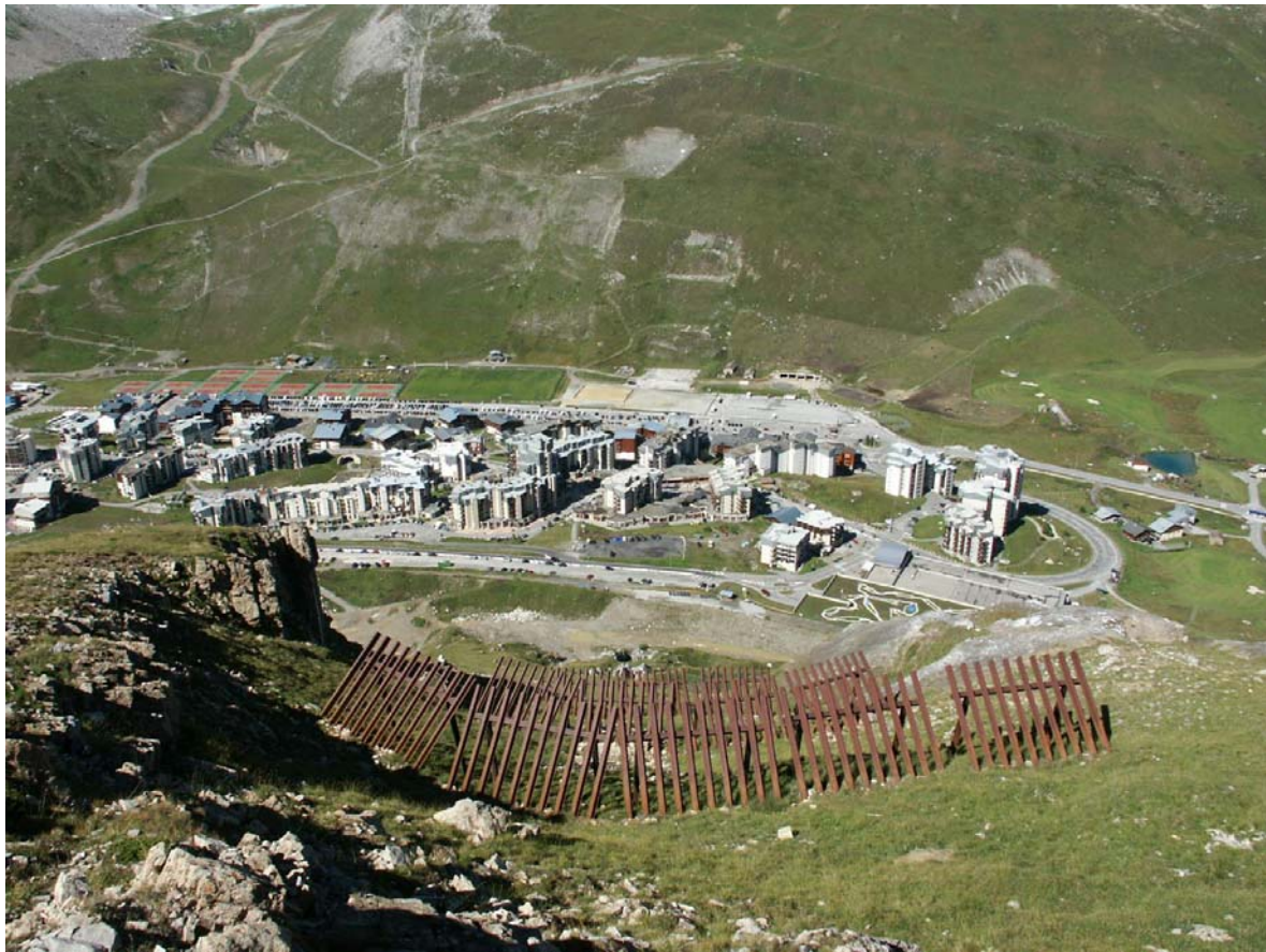
Ouvrage 43 : Râteliers en amont de Val Claret (cf fiches pages 69-70)
