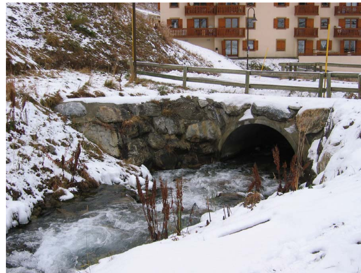
Ouvrage 41 : Enrochements maçonnés ponctuels. Protection contre les crues du ruisseau du Lac (cf fiche page 61)
