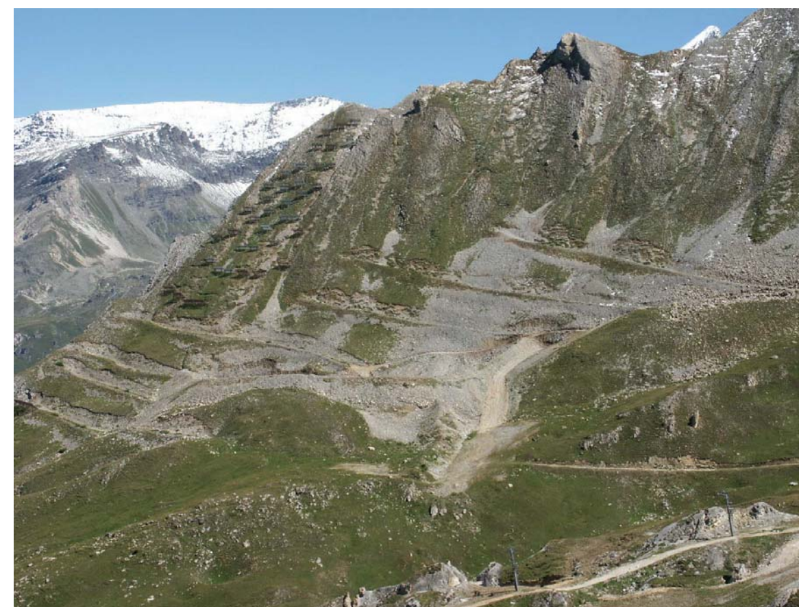
Ouvrages 26 et 28 : Banquettes larges et râteliers sur le flanc OSO de la pointe du Lavachet (cf fiches pages 49-50)
