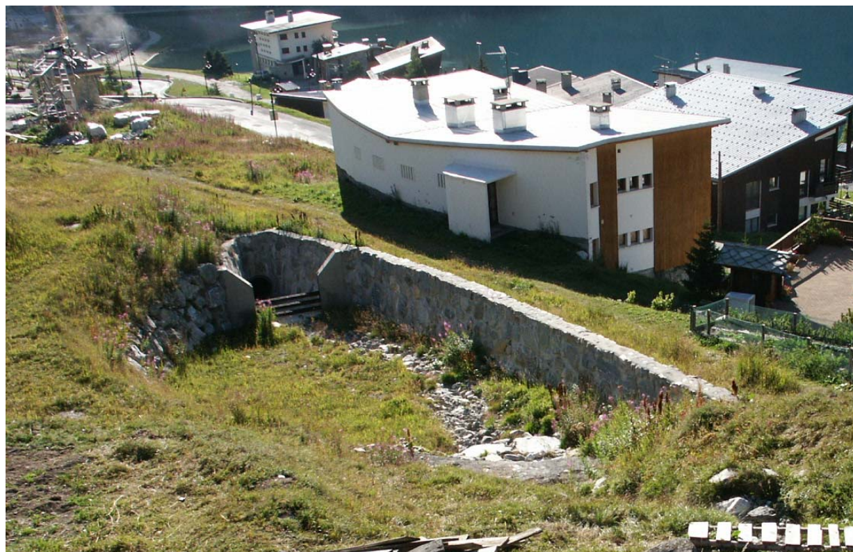
Ouvrage 39 : Plage de dépôt. Protection contre les crues du torrent du Beau Plan (cf fiche page 56)
