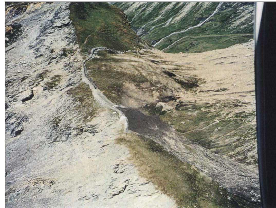
Ouvrage 8 : Ouvrage de retenue et de dérivation vers le bassin versant du Nant Cruet (alt. 2810 m environ). Protection contre les crues du torrent de la Davie. cf fiche page 26-27
