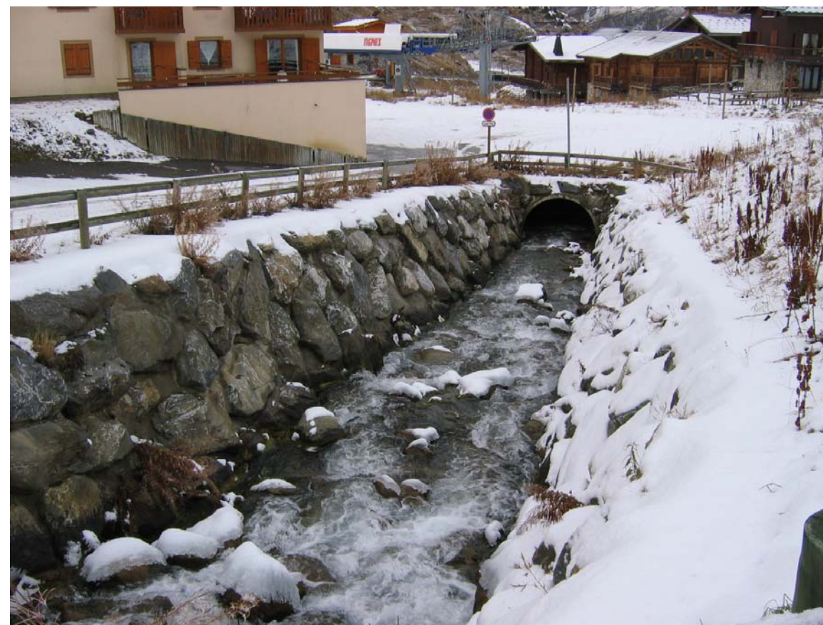
Ouvrage 41 : Enrochements maçonnés ponctuels. Protection contre les crues du ruisseau du Lac (cf fiche page 61)
