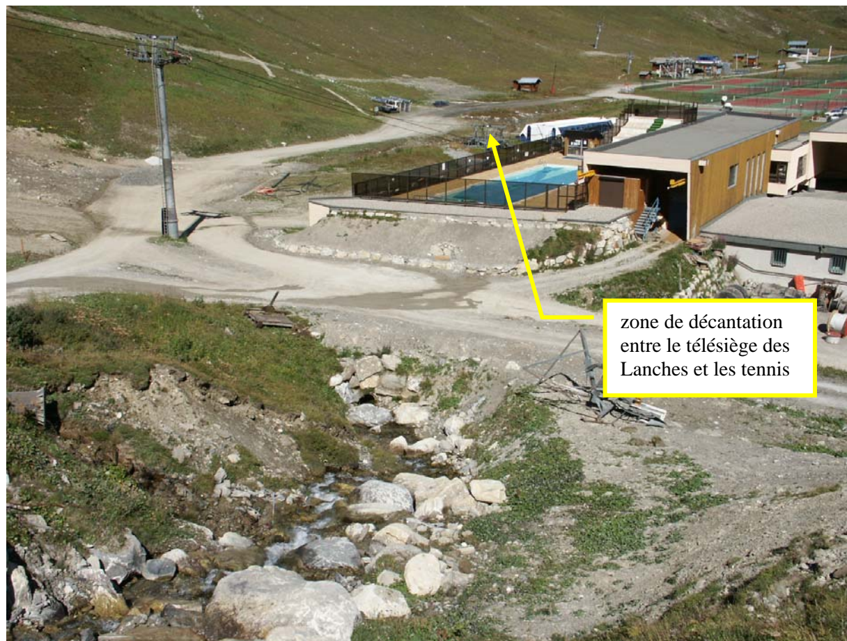
Ouvrages 48 et 49: Aménagements des conditions d'écoulement sur la piste Double M et au niveau du télésiège des Lanches. Protection contre les crues du torrent des Balmes (cf fiche page 75)
