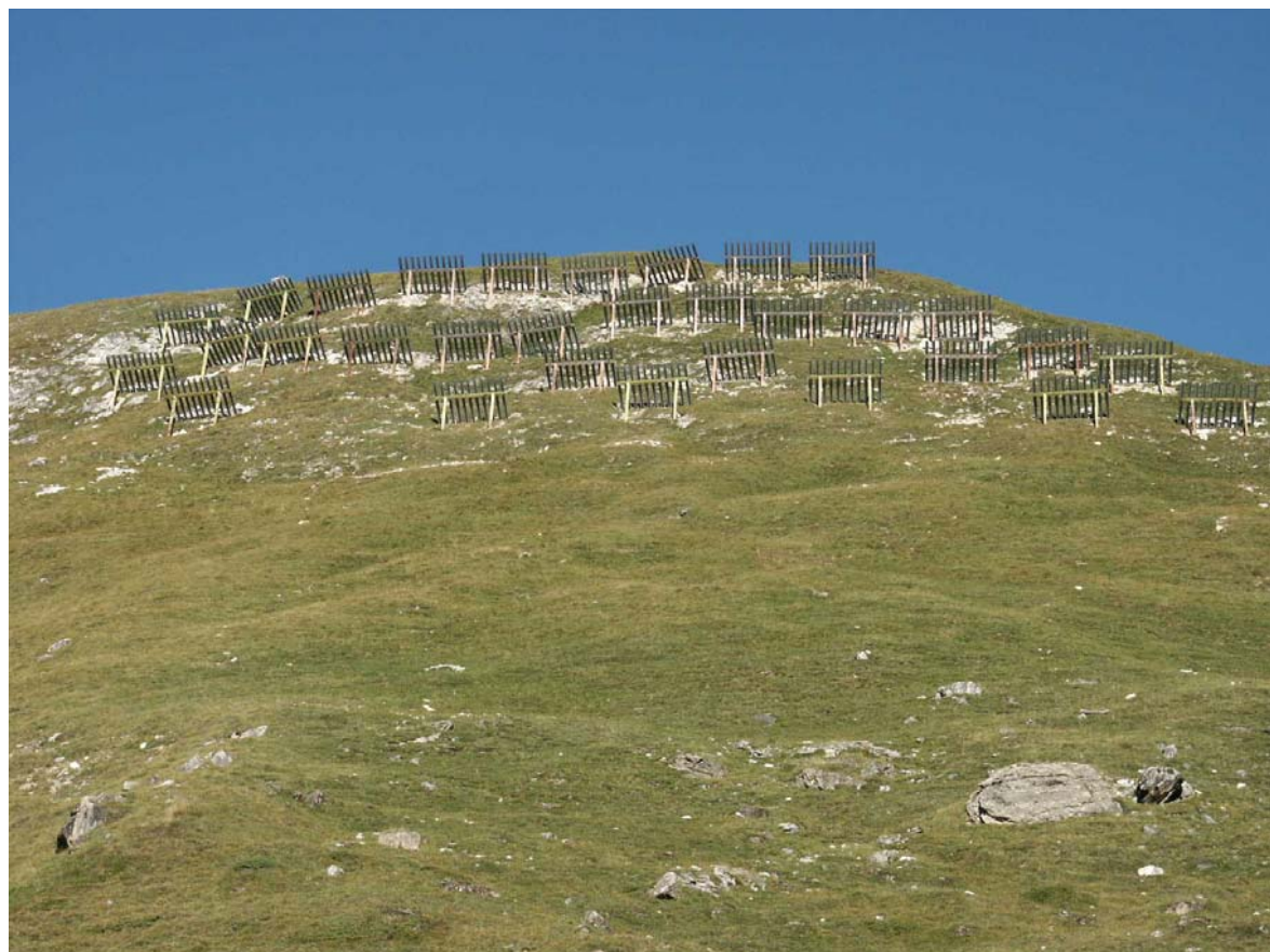
Ouvrage 33 : Râteliers en rive gauche de la Combe du Chardonnet (cf fiche page 54)
