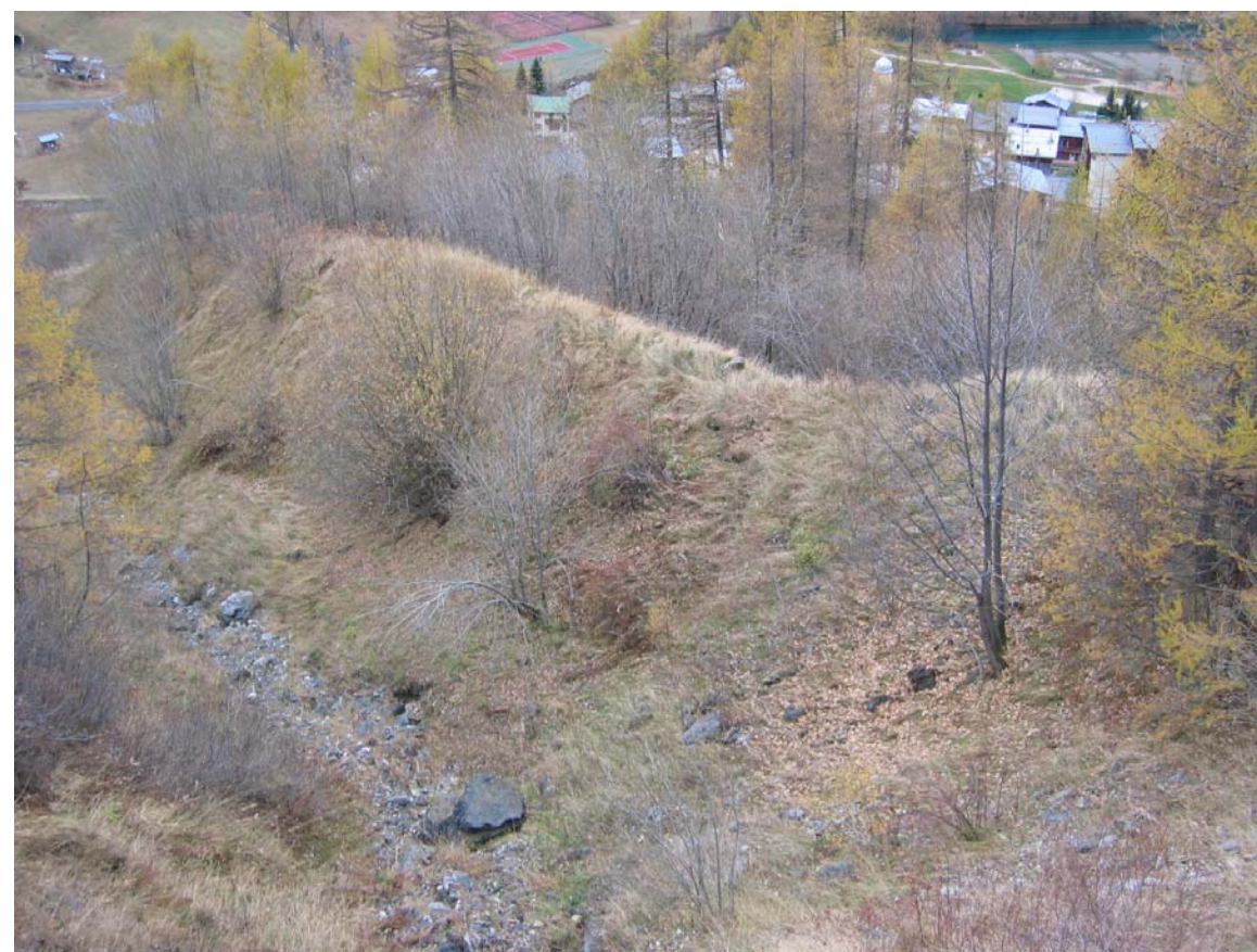
Ouvrage 5 : Tourne en remblais (rive droite) en aval immédiat de la RD902. Protection contre les crues du torrent et les avalanches de la Davie - cf. fiches pages 18-19 et 26-27
