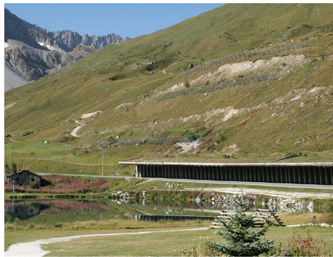
Ouvrages 37 et 38 : Galerie paravalanche du Lac de Tignes, filets et banquette large (golf) (cf fiches pages 55 et 64)
