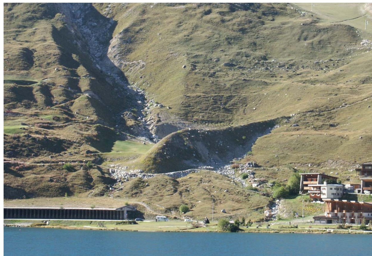
Ouvrage 34 : Tourne paravalanche (cf fiche page 54). Protection également contre les crues du ruisseau du Chardonnet (cf fiche page 58)
