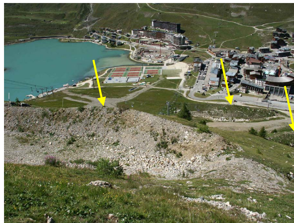
Ouvrage 21 : Digues paravalanches, assurant également une protection pare-blocs, en amont du Rosset (cf fiches pages 49-50)
