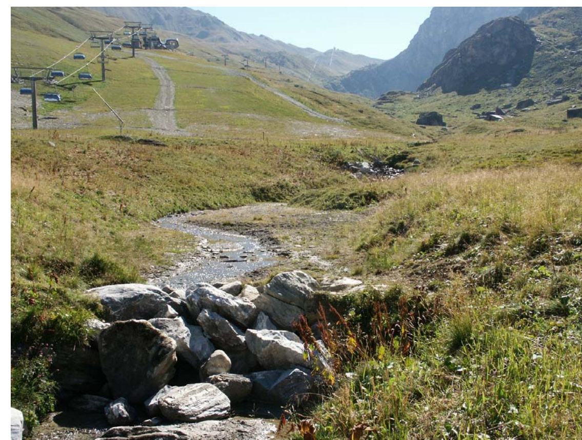
Ouvrage 47 : Plage de dépôt. Protection contre les crues du torrent le Retort (cf fiche page 75)
