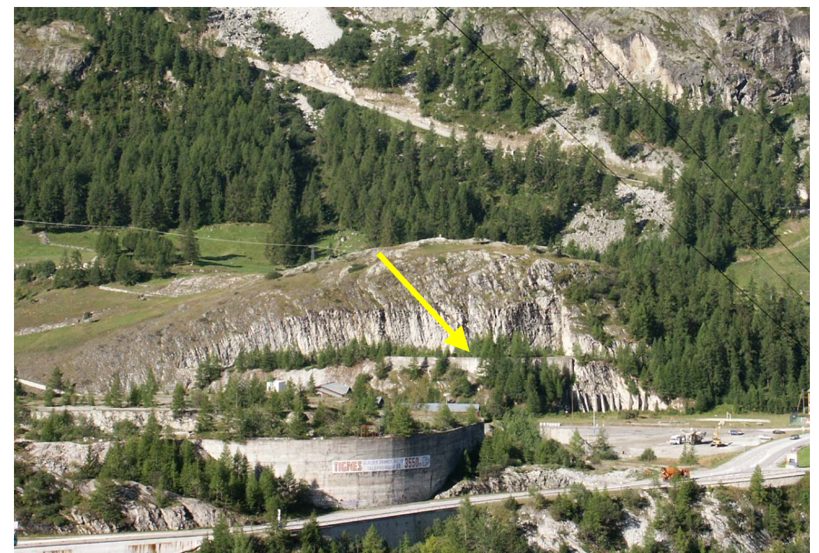
Ouvrage 13 : Plate-forme d'une dizaine de mètres de largeur, à mi-pente. Protection contre les chutes de pierres et blocs (cf fiche page 36)
