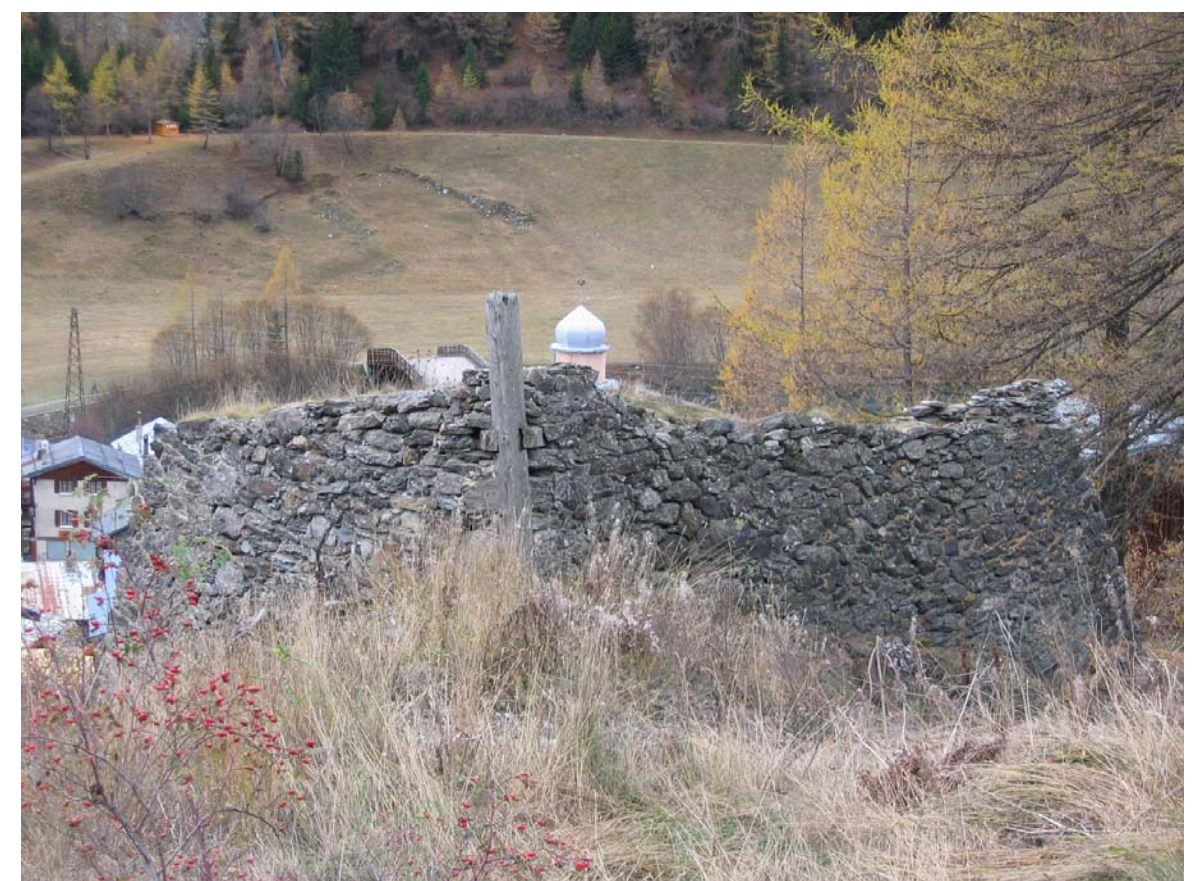
Ouvrage 6 : Etrave protégeant le village contre les crues du torrent et les avalanches de la Davie. cf fiches pages 18-19 et 26-27
