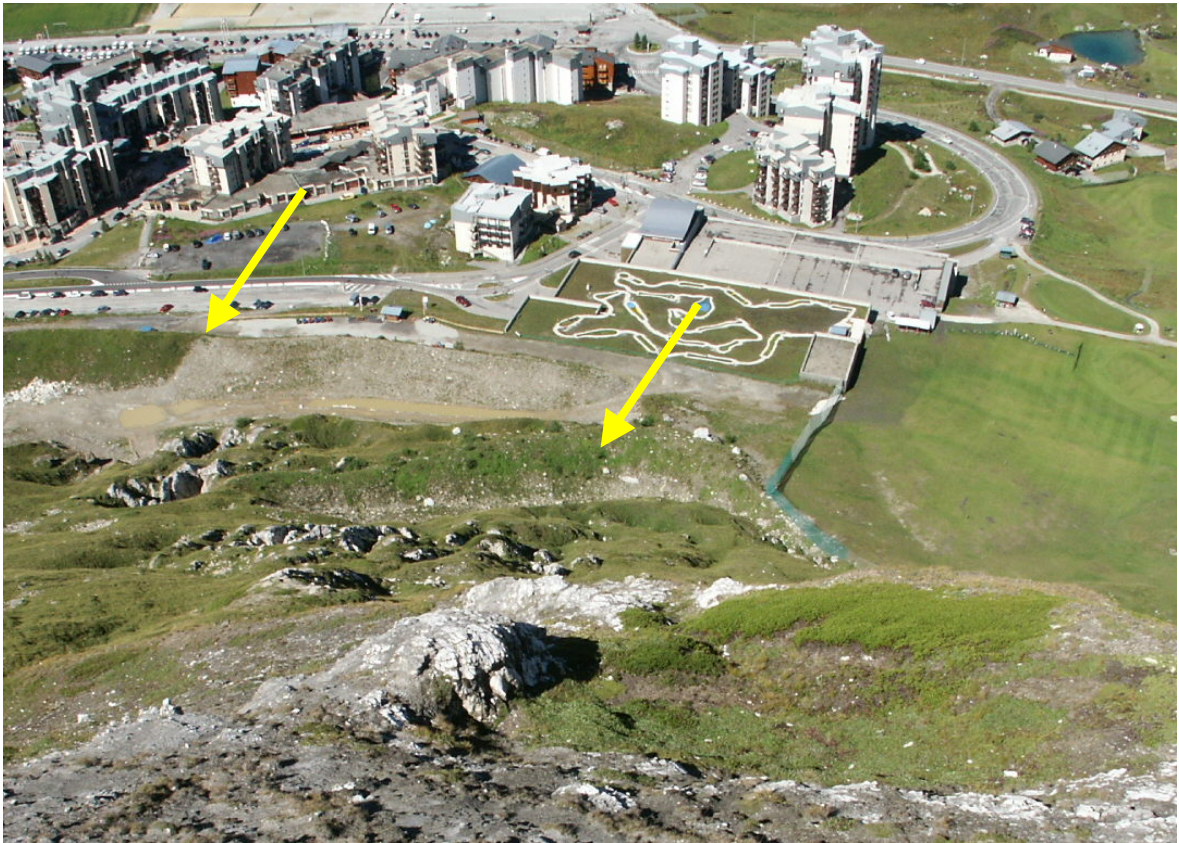
Ouvrage 44 : Digues protégeant Val Claret de l'avalanche n°21 de la CLPA (cf fiches pages 69-70)
