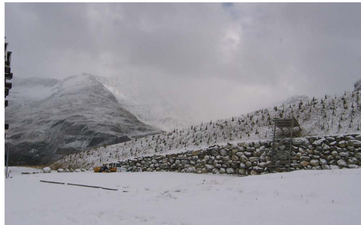
Ouvrage 21 : Extrémité nord (parement aval) de la tourne paravalanche, assurant également une protection pare-blocs, vis à vis du LAVACHET (cf fiches page 43 et page 47-48)
