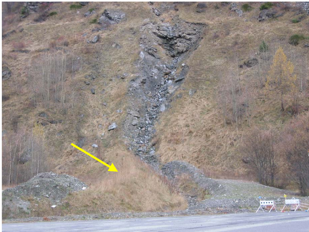
Ouvrage 7 : Digue en remblais (rive droite) en pied de versant (parking des Brévières). Protection contre les crues du torrent de la Davie (cf. fiches pages 26-27)
