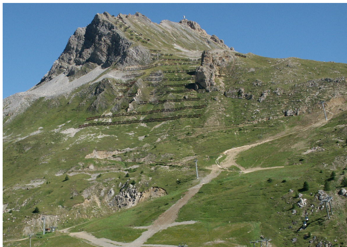
Ouvrages 28 et 29 : Râteliers (à gauche) et banquettes étroites (à droite) en amont du Rosset (cf fiches pages 49-50)
