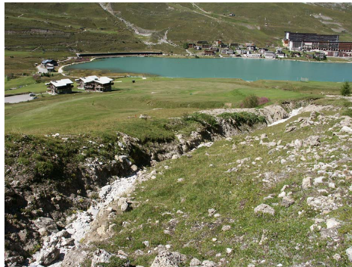
Ouvrage 46: Petite digue aménagée en rive gauche d'un chenal d'écoulement. Protection des bâtiments « les Chartreux » contre les coulées boueuses issues des Tufs (cf fiche page 74)
