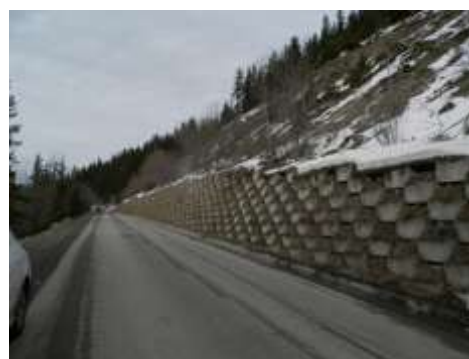
Figure 47 : ouvrage de confortement en béton du talus routier
