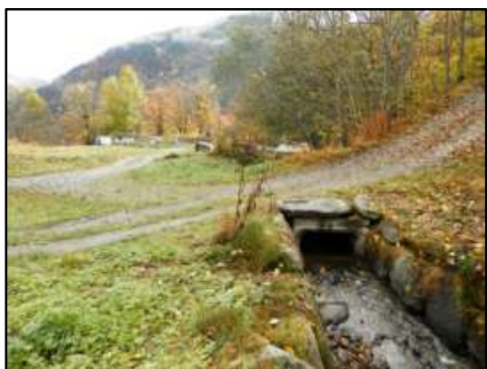
Figure 62 : dalot à l'aval de la plage de dépôt
