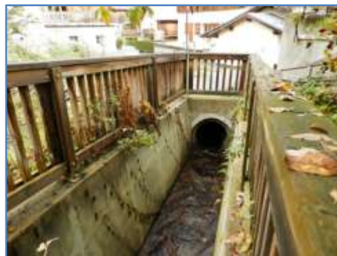
Figure 64 : entrée du passage busé
