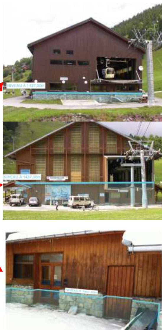
Figure 41 : Emprise de la crue centennale sur le secteur amont des Ravines et mise en évidence de la ligne d'eau à l'altitude 1437,30 mètres sur les habitations.
