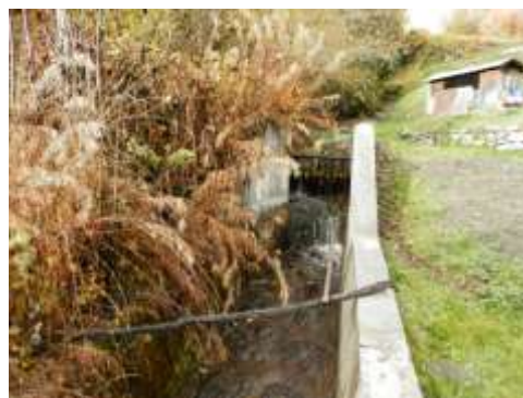
Figure 65 : grille de protection à environ 30 m de l'entrée de la buse, en partie obstruée par des feuilles
