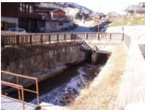
Figure 26 : entrée du dalot de la section couverte
