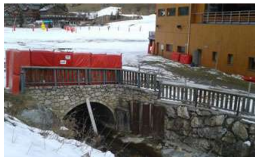
Figure 39 : entrée du passage busé au niveau du téléski du stade
