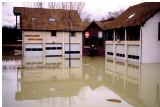
Caserne des pompiers crue de 1990
