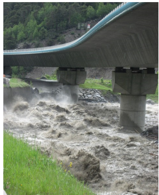
Figure 11 : Crue de mai 2008 : Saint André
