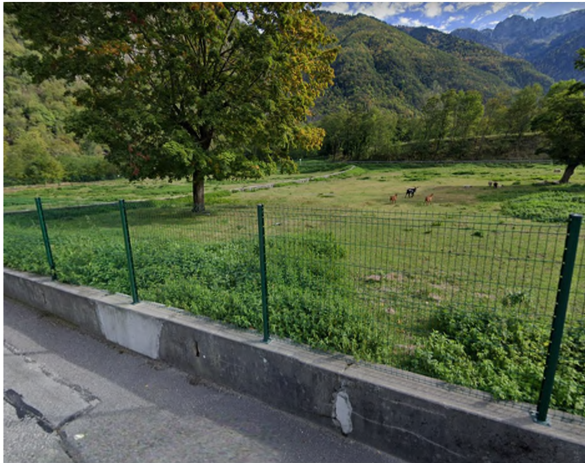
Figure 13 : Clôture entourant le site de l'ancienne décharge (source : Google Street View)
