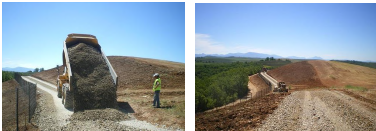
Figure 15 : Exemple de travaux de préparation du site (source : TotalEnergies Renouvelables)
