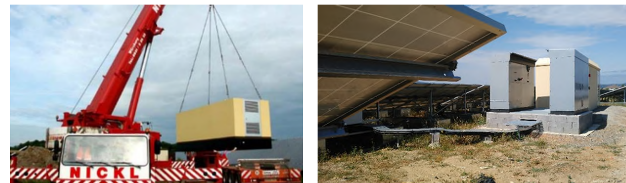
Figure 17 : Acheminement et installation des postes transformation et livraison (source : TotalEnergies Renouvelables)
