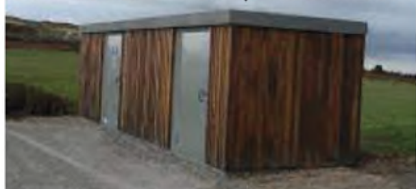
Détail du traitement du poste de livraison
