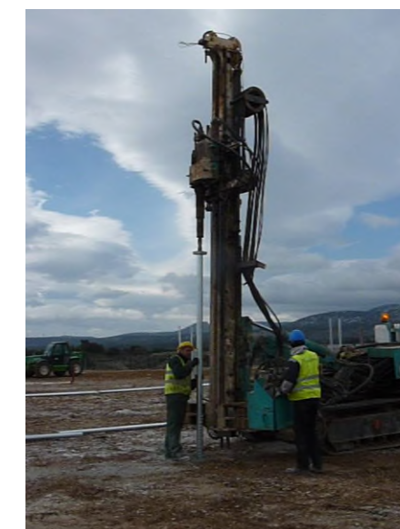
Figure 10 : Structure gabion et installation de pieux battus/vissés (source : TotalEnergies renouvelables)
