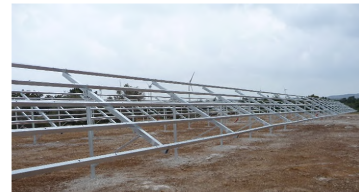
Figure 16 : Exemple de travaux de préparation du site (source : TotalEnergies Renouvelables)
