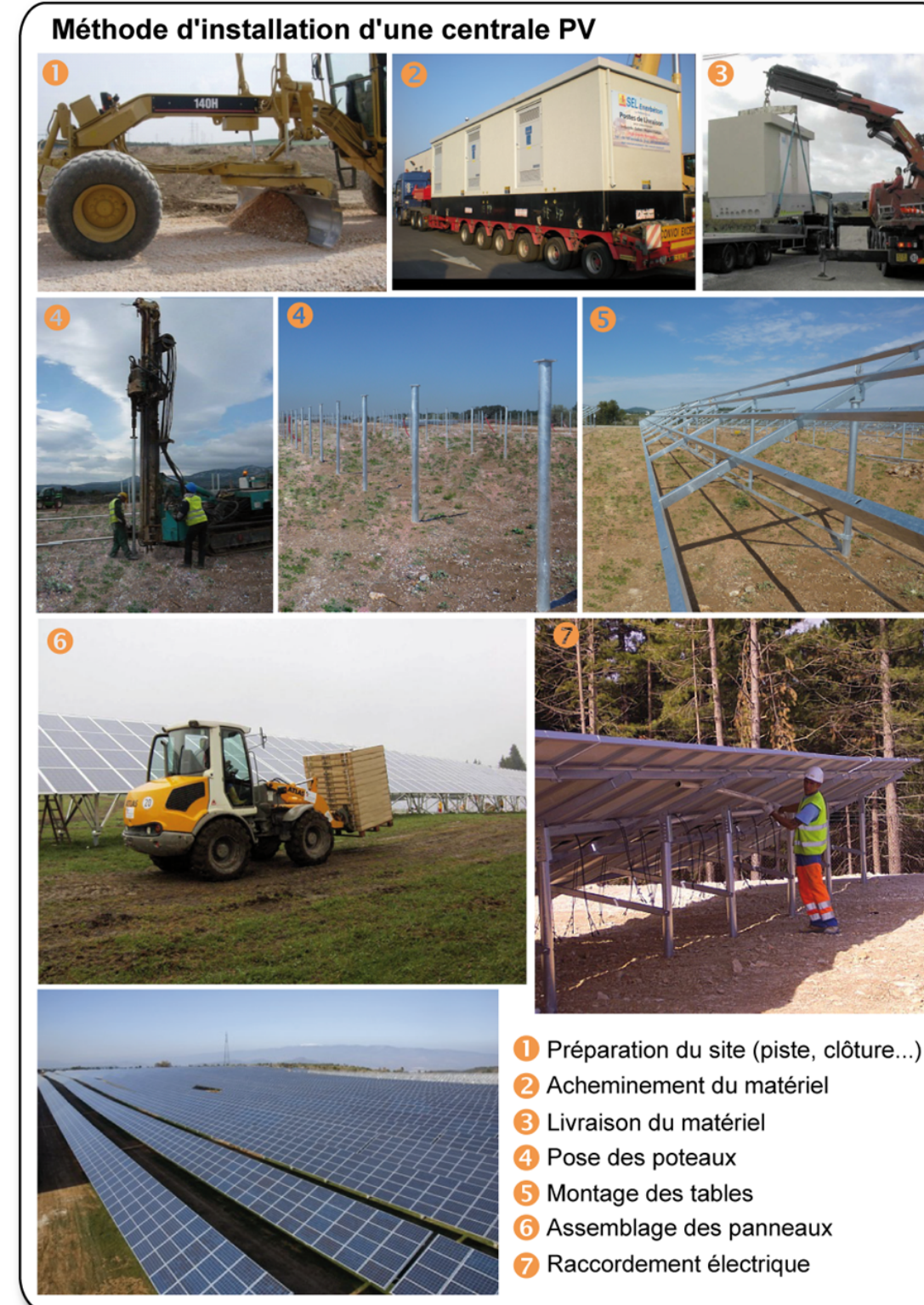
Figure 14 : Méthode d'installation d'une centrale photovoltaïque (source : TotalEnergies Renouvelables)
