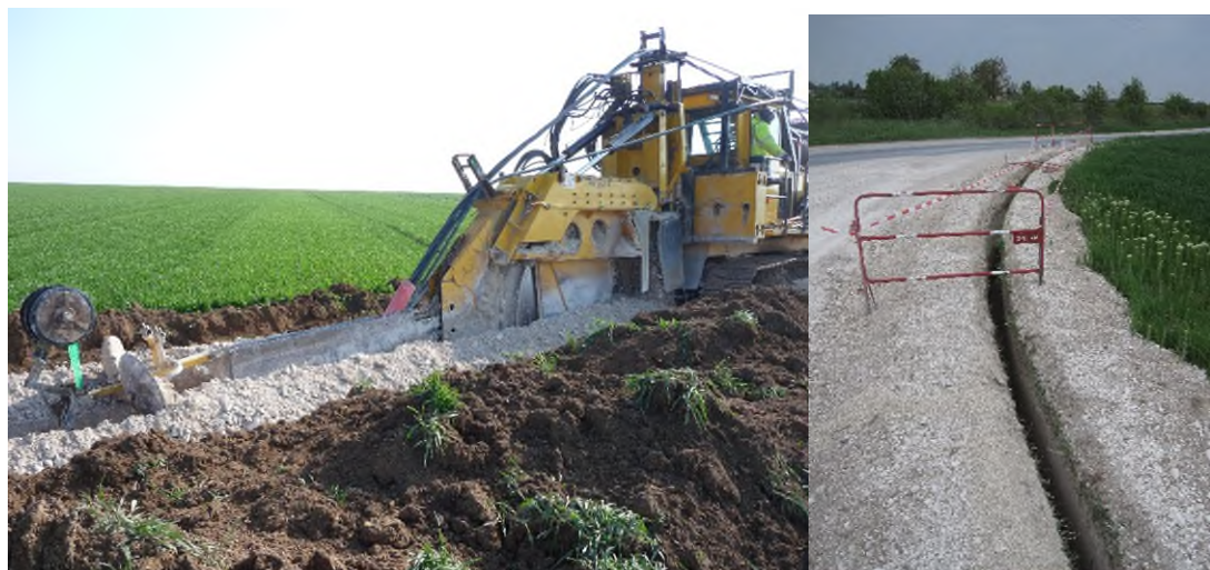
Figure 18 : Exemple de tranchées réalisées (source : TotalEnergies Renouvelables)
