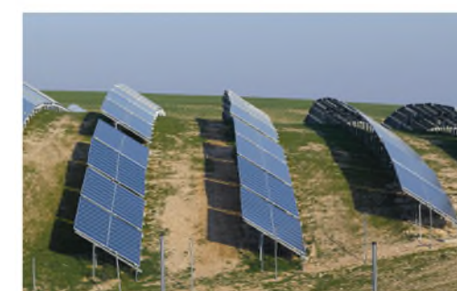
Exemple d'implantation de modules sur des terrains en pentes transversales, permettant de suivre le relief et éviter des cassures visuelles trop importantes.
