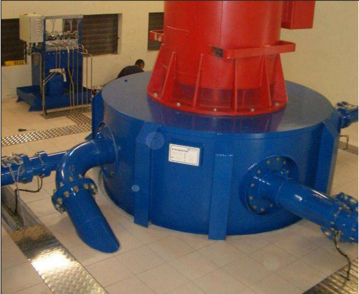
Exemple de turbine Pelton 4 à axe vertical. Source : SERHY.
