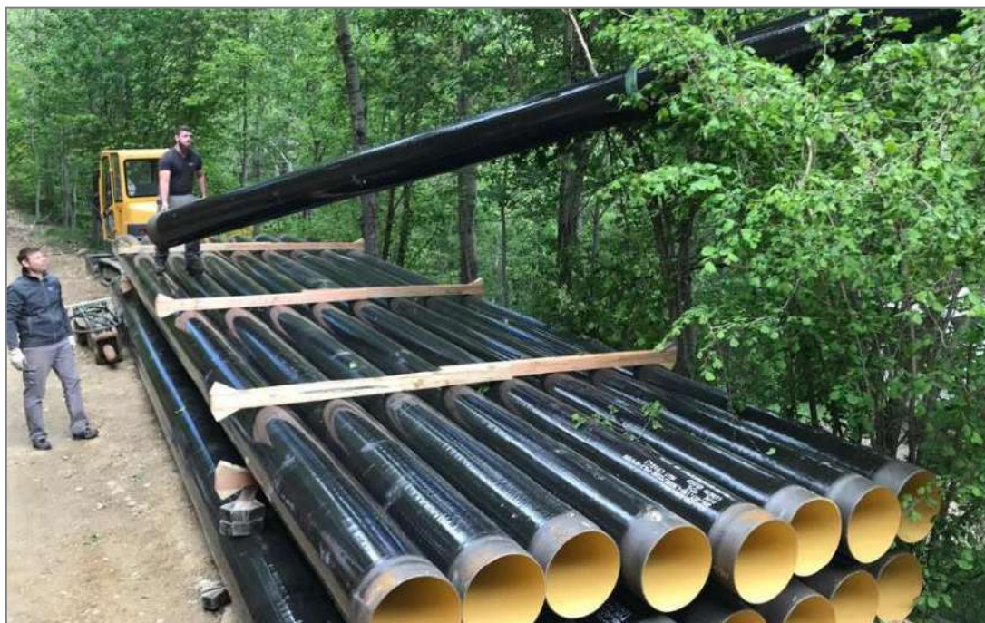
Figure 13 – Exemple de stockage de tubes sur chantier de Nohèdes – Juin 2021
