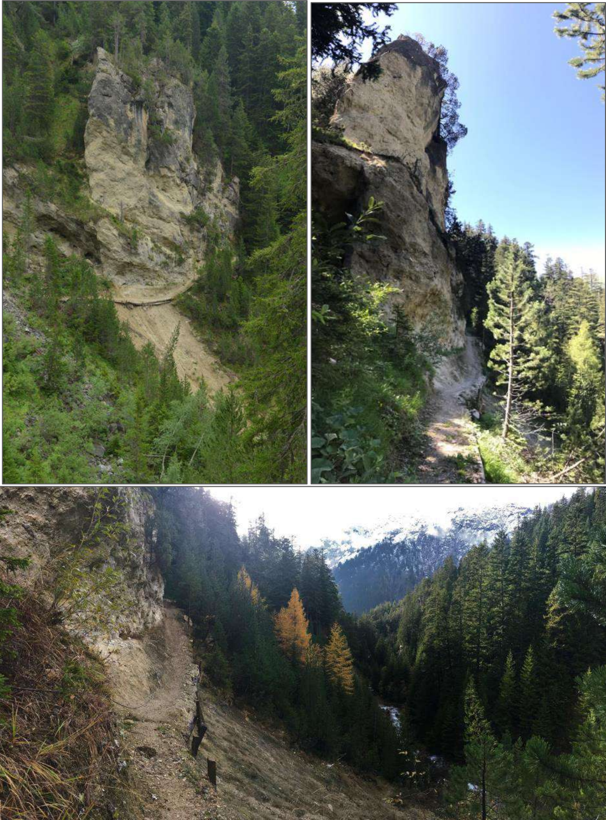
Figure 23 – Vues du passage en pied de piton qui nécessitera un aménagement de type soutènement en gabion et remblais pour permettre la progression des engins de chantier et le passage de la conduite
