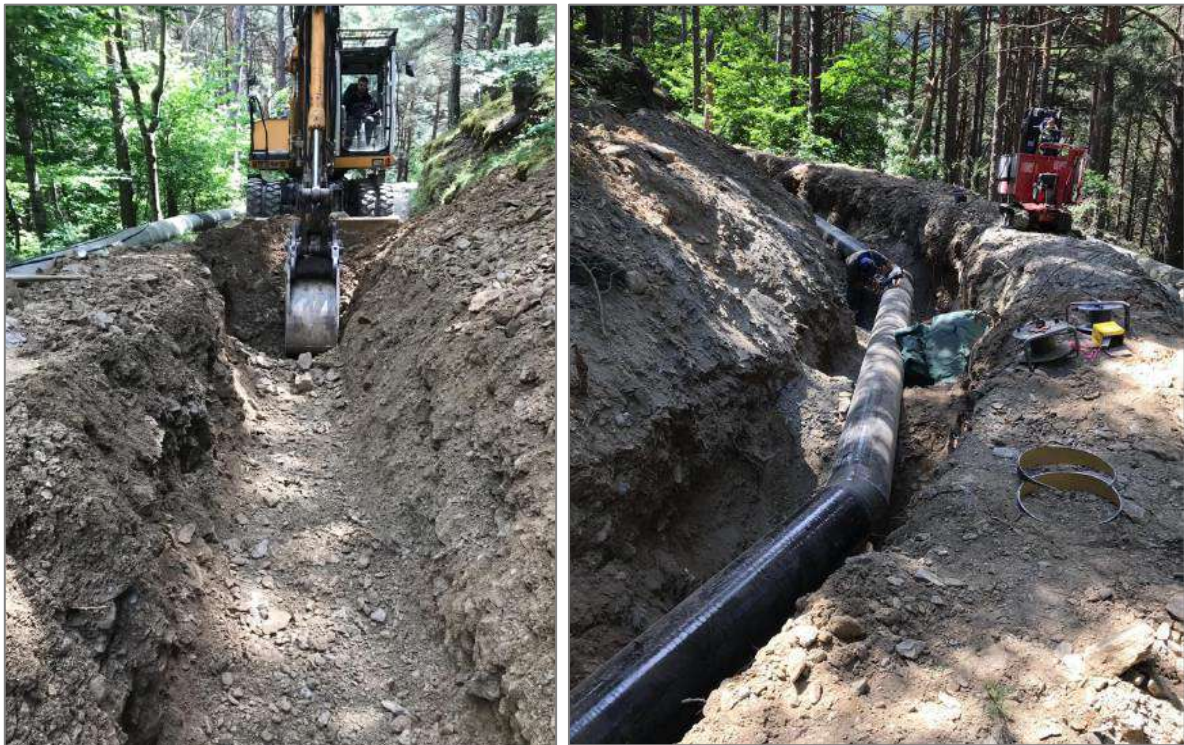
Figure 22 – Exemple de chantier de pose de conduite – Nohèdes – Juin 2021
