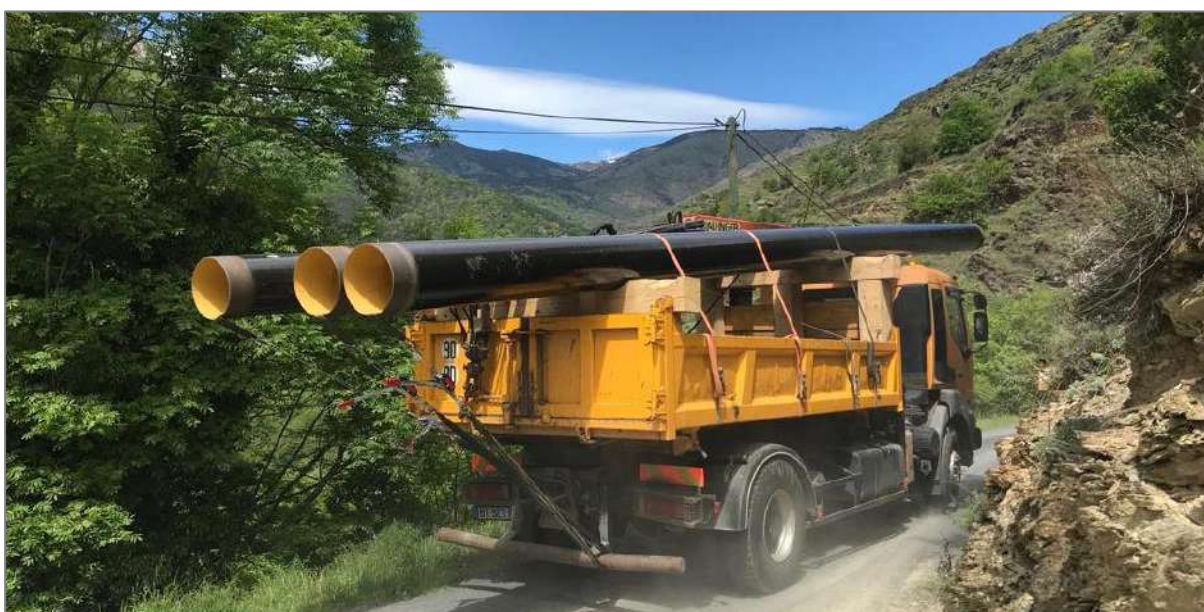
Figure 14 – Acheminement des tubes sur chantier de Nohèdes – Juin 2021
