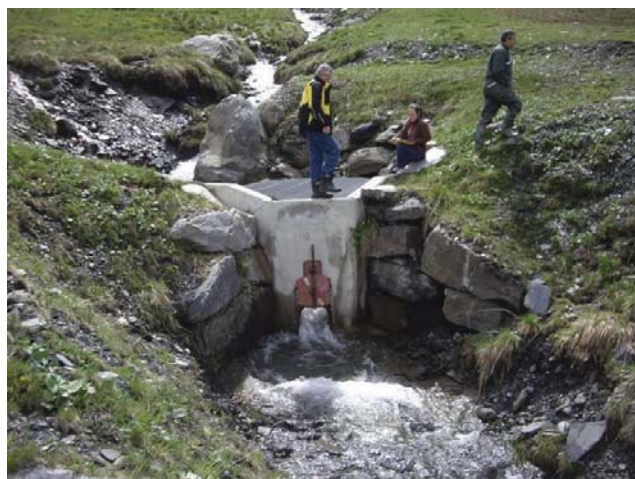
Ouvrage de prise d'eau dans le ruisseau des Plans (ABEST, 2011)
