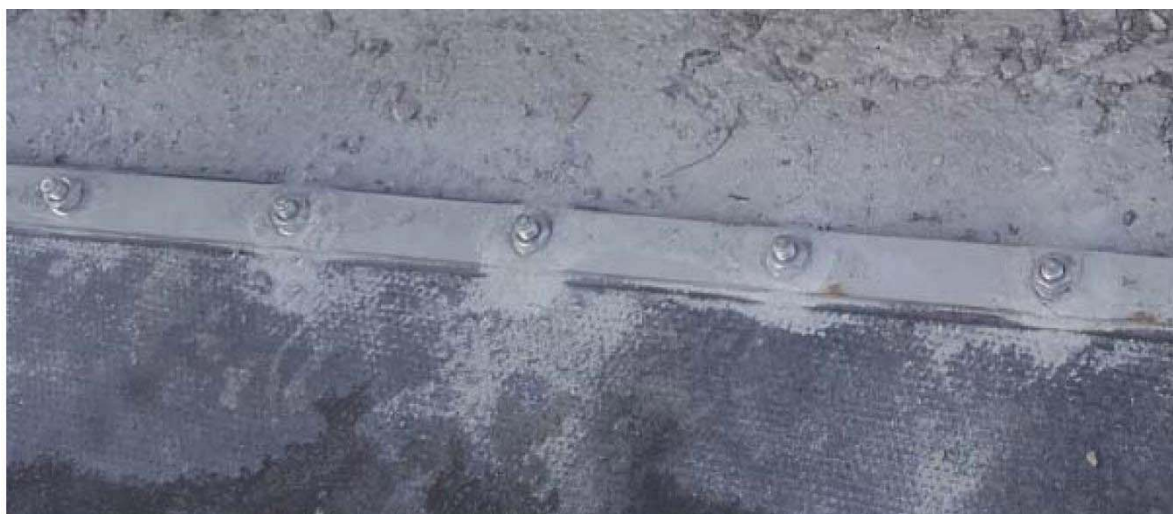
Exemple de fixation de la géomembrane
