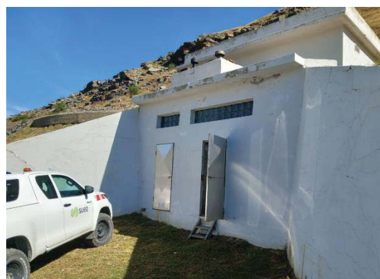
Réservoir du stade
