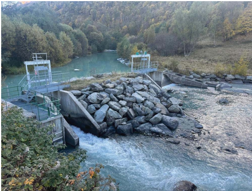
Barrage des Iles à St Marcel
