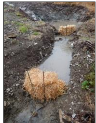
Figure 1 - Exemple d'un système de filtration d'un cours d'eau. Crédit : KARUM
