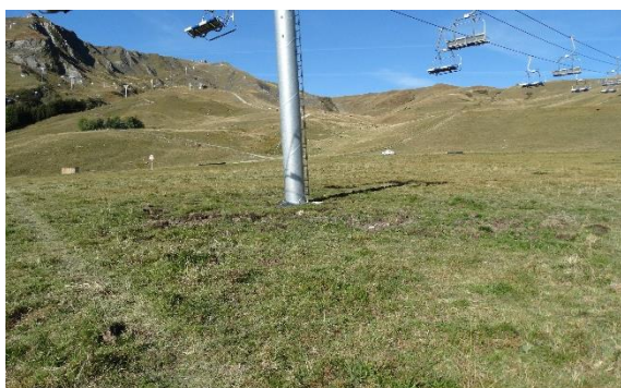
Emprise de fouille de pylône et tranchée de réseau neige revégétalisés par étrépage (contexte de zone humide) : 1 an après travaux (2017)
