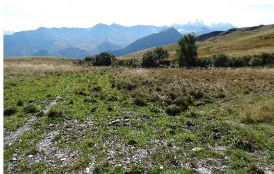
Emprise de fouille de pylône et tranchée de réseau neige revégétalisés par étrépage (contexte de zone humide) : 1 an après travaux (2017)
