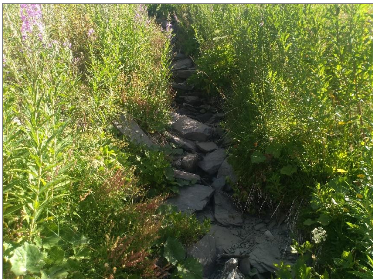
Drain au sein de la zone d'étude au 24/08/2023 (Karum)
