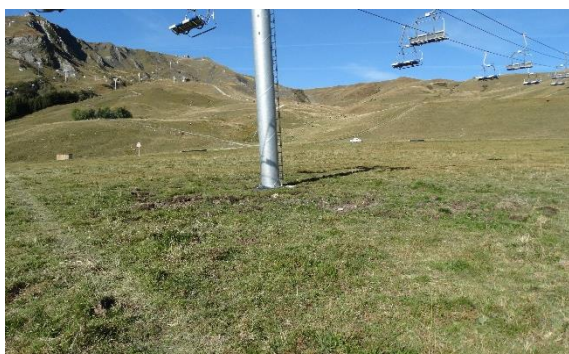
Emprise de fouille de pylône et tranchée de réseau d'adduction revégétalisés par étrépage (contexte de zone humide) : 1 an après travaux (2017)
