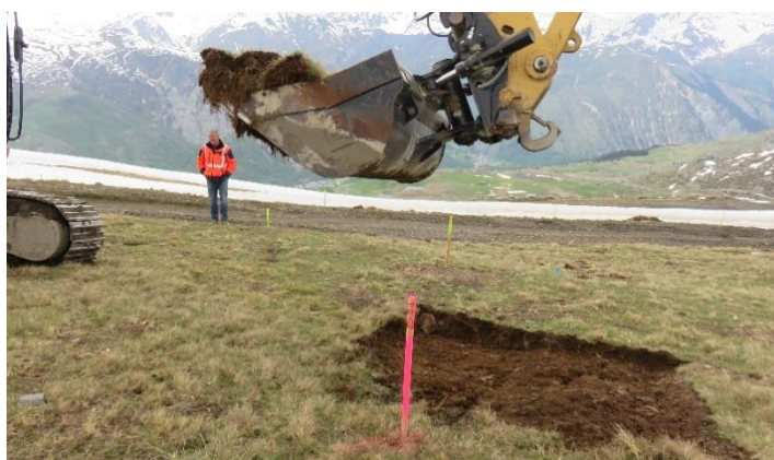
Test d'étrépage, godet plat et stockage des mottes (KARUM, Mai 2018)
