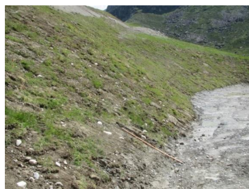
Ci-contre : Talus végétalisé par étrépage : Après travaux (Aout 2016) et 1 an après la fin des travaux (2017)
