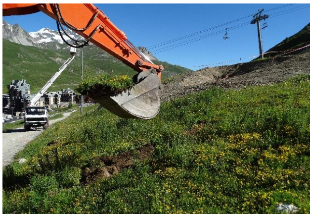
Ci-contre : Talus végétalisé par étrépage : Après travaux (Aout 2016) et 1 an après la fin des travaux (2017)
