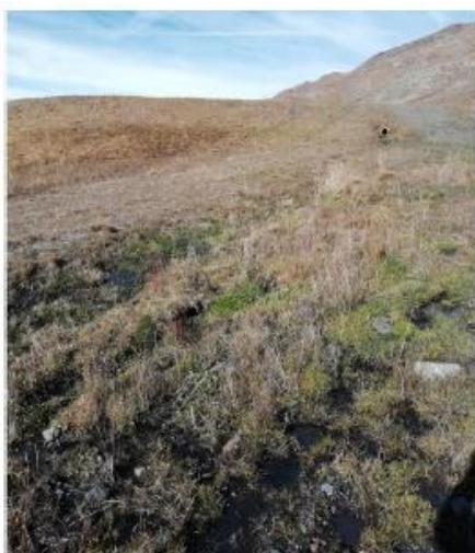
Fossé à l'aval du la buse sud
