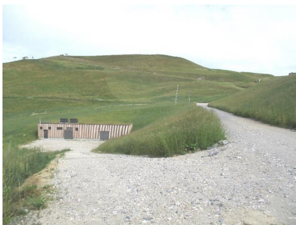
Exemple d'intégration paysagère d'une salle des machines aux Saisies : objectif recherché similaire pour la retenue des Echauds, avec un parement pierres en remplacement du bardage bois – Source : KARUM
