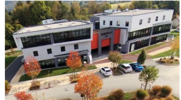
Bureaux et services, stationnements en sous-sol immeuble Oppidum Challes-les-Eaux
