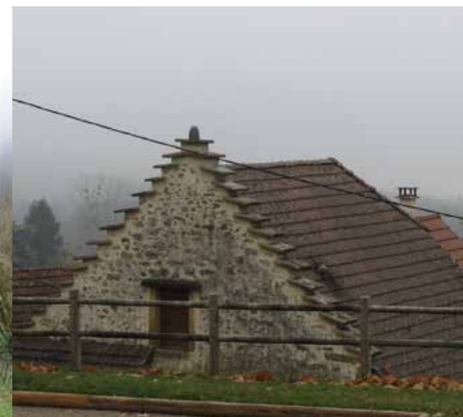
Maison dans le pays de Novalaise - Toiture en «Saut de moineaux» / Source : DDT 73
