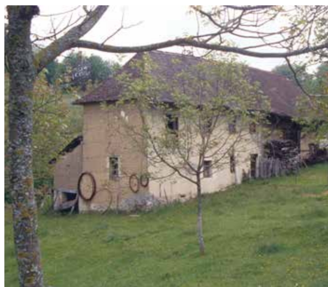
Ferme isolée en pisé à Avressieux (val de Guiers) / Source : UDAP
