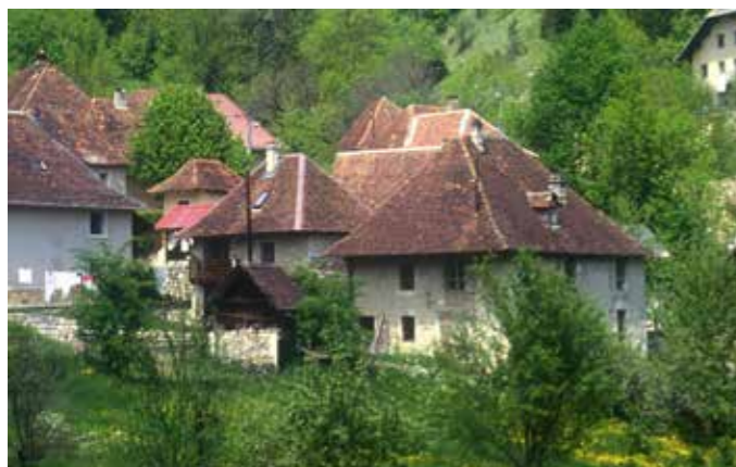
Maisons carthusiennes avec toitures à 4 pans en tuiles: Saint-Pierre-d'Entremont / Source : CAUE de la Savoie
