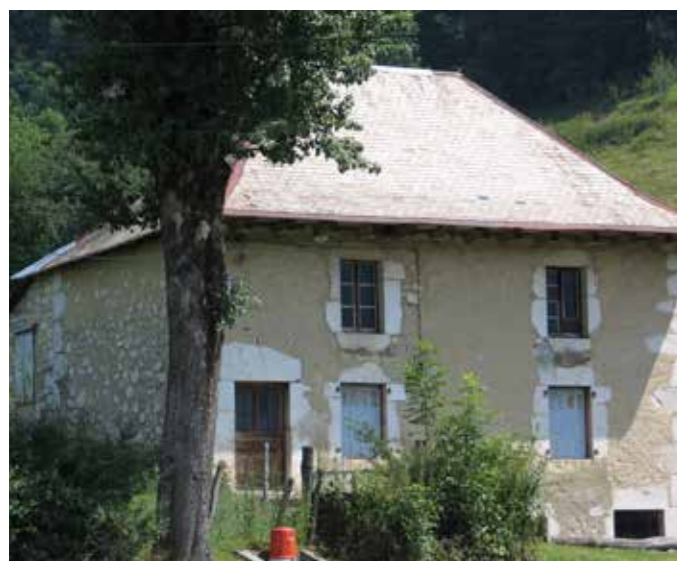
Maison carthusienne - Corbel / Source : PNRC
