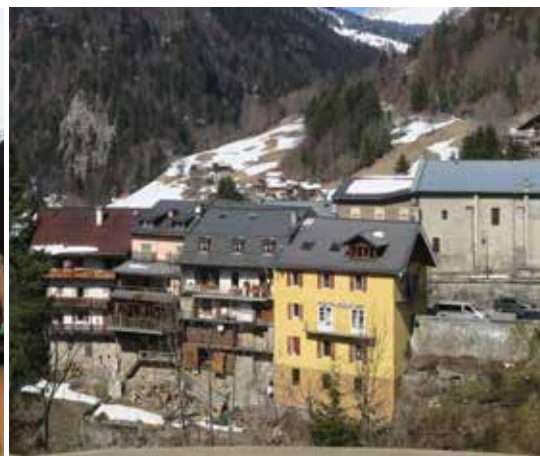
Facades bâties surplombant l'Arly à Flumet / Source: Atelier UO
