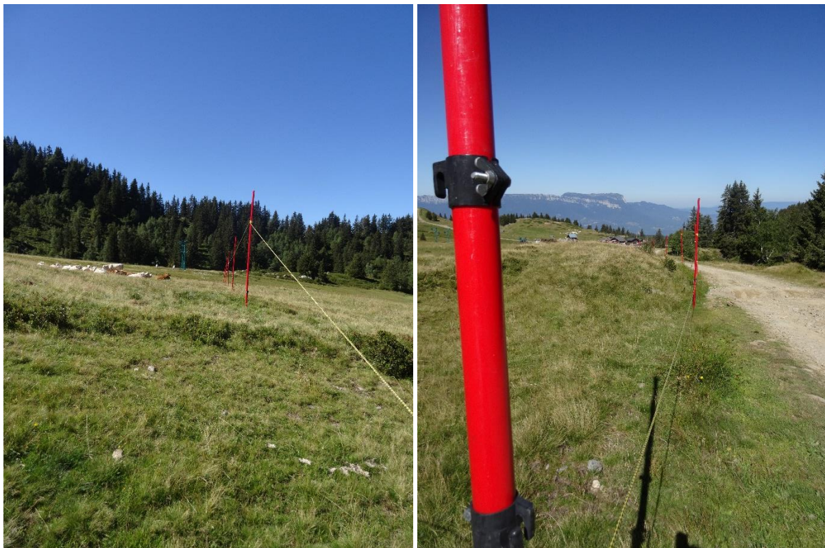
EXEMPLE D'UNE MISE EN DEFENS DE ZONE HUMIDE SUR UN CHANTIER DE REMPLACEMENT DE REMONTEE MECANIQUE, MDP 2016
