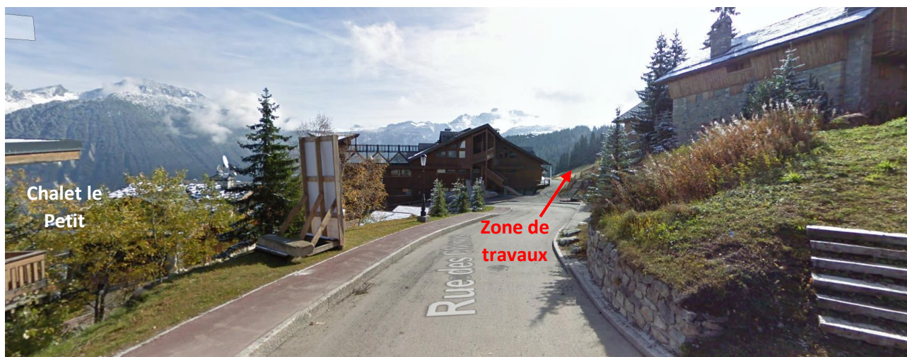
VUE DEPUIS LA ROUTE A PROXIMITE DU CHALET LE PETIT NAVIRE
