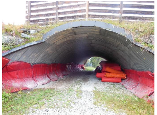
EXEMPLE DE PASSAGE BUSE POUR LES SKIEURS
