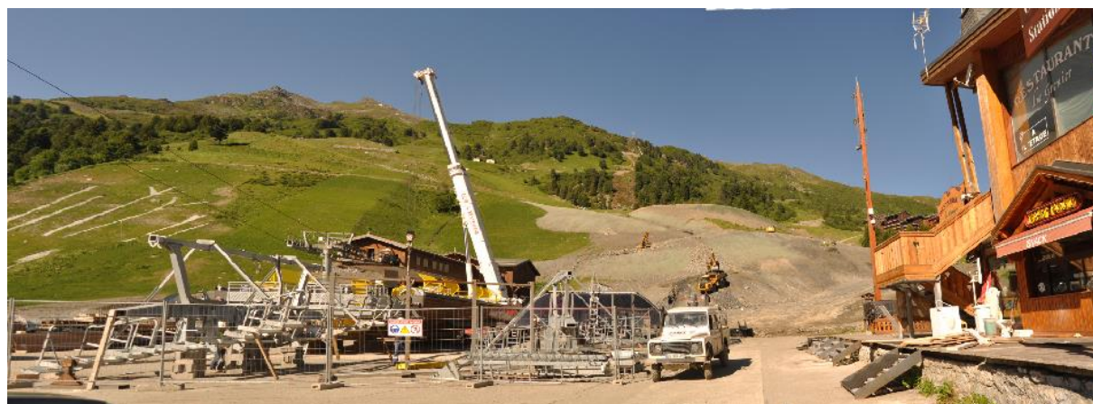
6 JUIN 2015 (CONSTRUCTION DU TSD6 DES COMBES)
