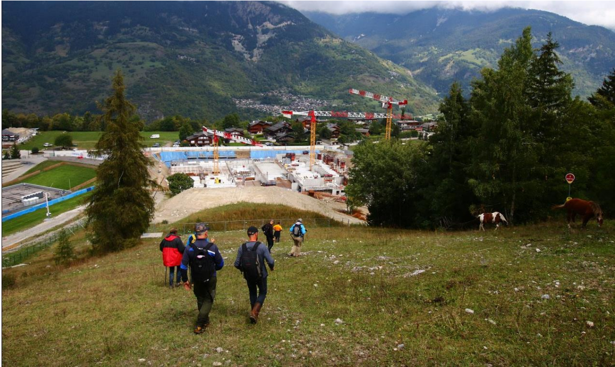
TRAVAUX EN COURS SUR LE PRAZ – LE 15 SEPTEMBRE 2018 – CLICHE : MAIRIE DE COURCHEVEL
