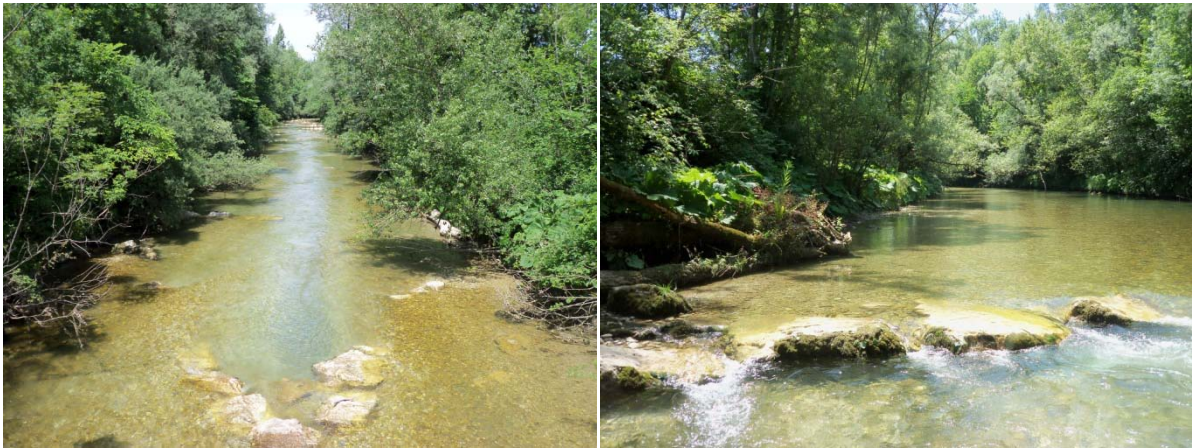
Figure 62 - Aménagements piscicoles du Guiers Mort mis en place durant l'été 2011
