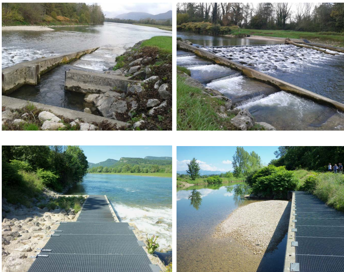
Figure 41 - passes à poissons au niveau du seuil CNR
