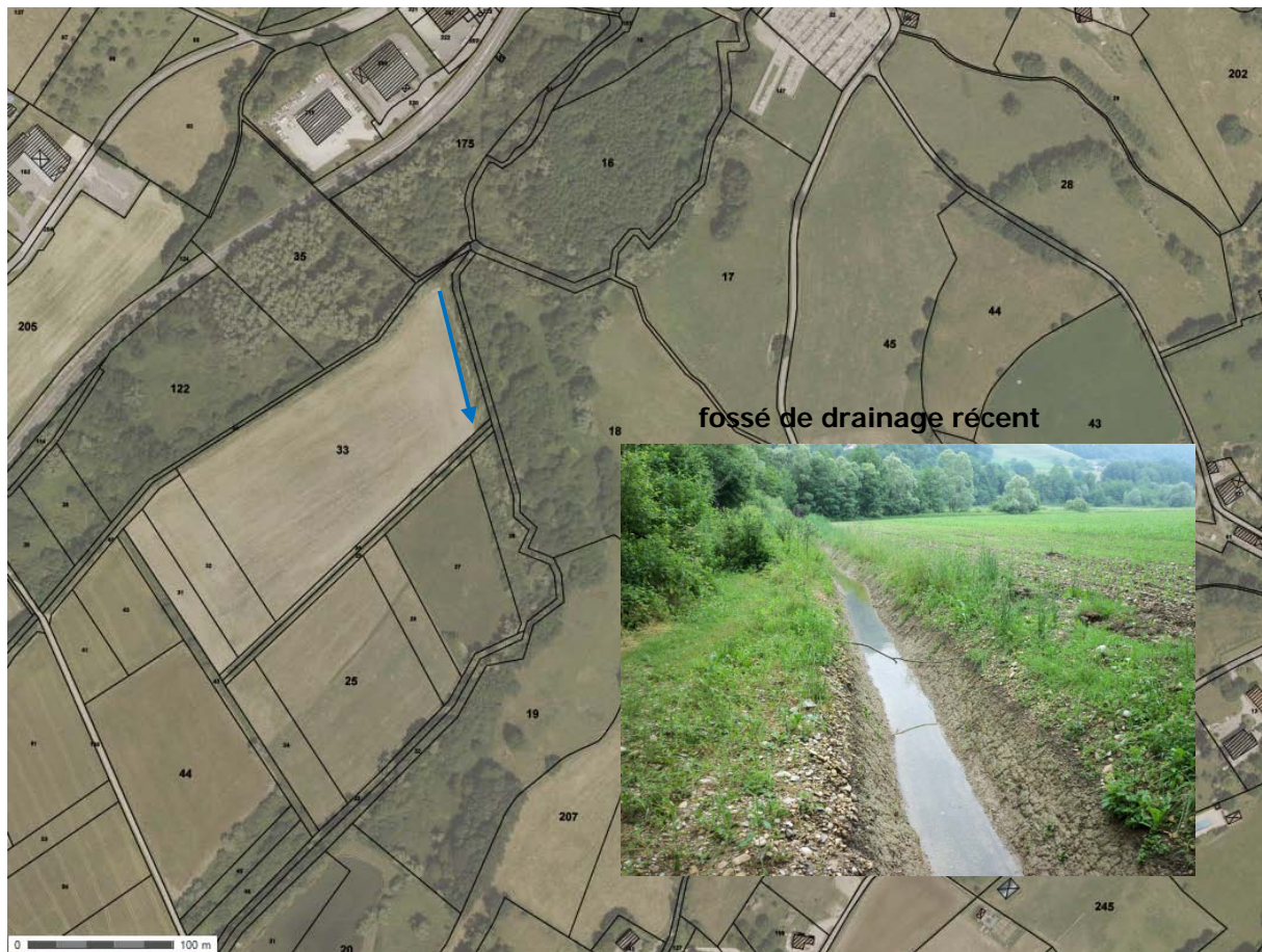
Figure 105 - Localisation et photo du fossé de drainage agricole récemment terrassé
