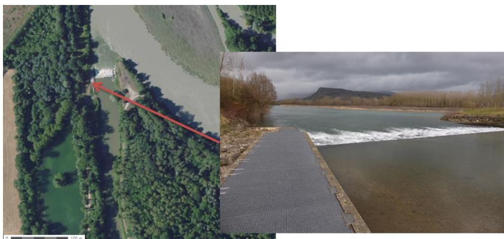
Figure 36 : Vue du seuil à la confluence avec le Rhône
