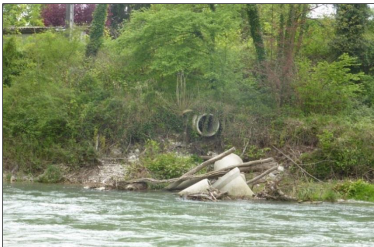
Figure 27 : Vue de la berge gauche érodée et de la conduite d'eau pluviale D800 endommagée
