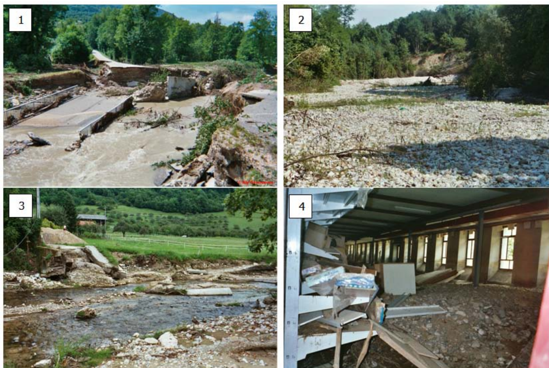
Figure 98 - Conséquences et dégâts occasionnés sur l'Ainan par la crue du 6 juin 2002 (source : ALPGEORISQUE, 2003) : photo 1 (pont de la RD82 emporté), photo 2 (engravement du lit à l'aval du site MIVA), photo 3 (destruction du pont de la Balme), photo 4 (engravement dans l'usine MIVA, entre 1 et 1,5 m de dépôt à l'intérieur du bâtiment)
