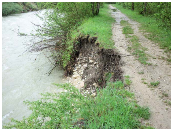
Figure 74 - Anse d'érosion récente en rive gauche du Guiers Mort
