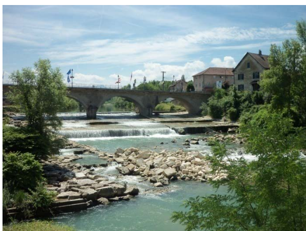
Seuil du Pont de Saint Genix et fosse de dissipation en aval
