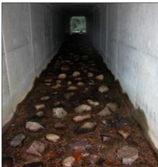
Figure 42 : Photo d'un cadre bétonné habillé (Source : ONEMA)
