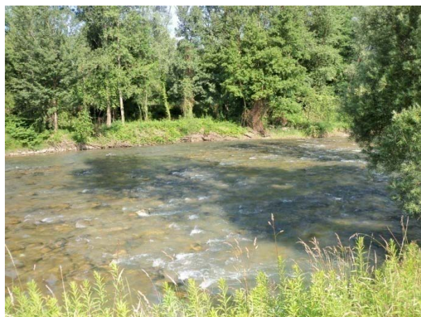
Radier sur la partie aval du site
