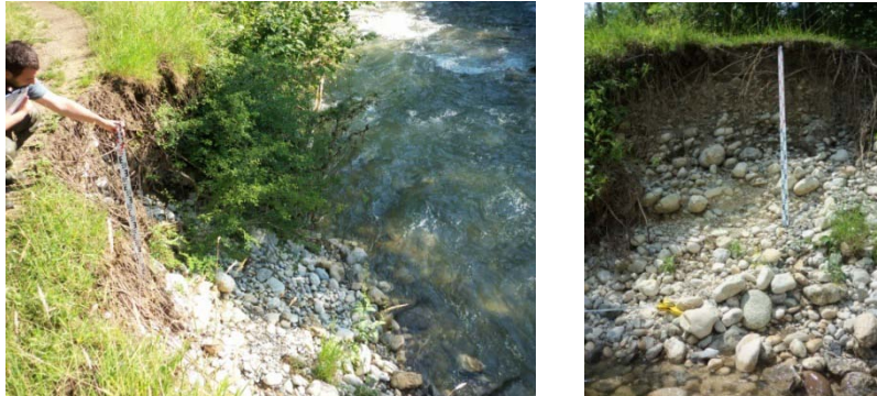
Exemple d'érosion de berge observée sur le Guiers à St-Laurent (site B-1-1-3)
