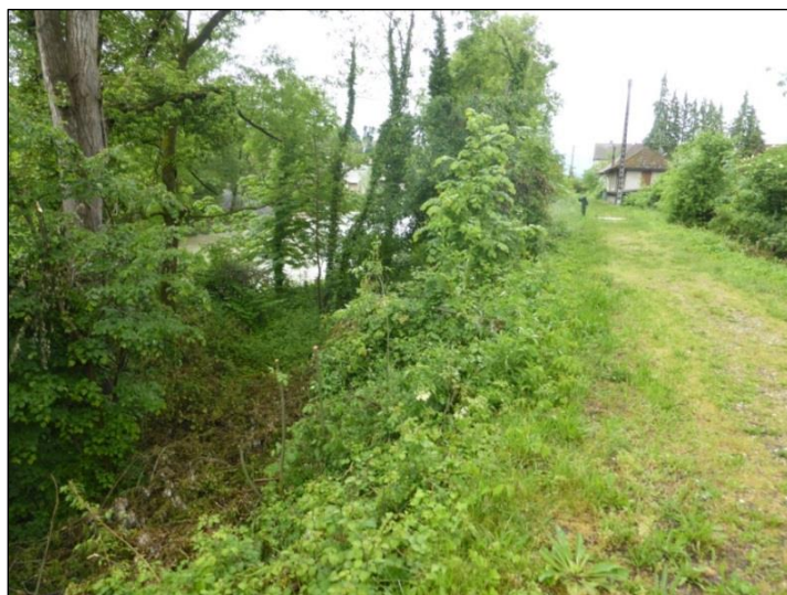
Figure 6 : Vue de la digue et de la risberme existante
