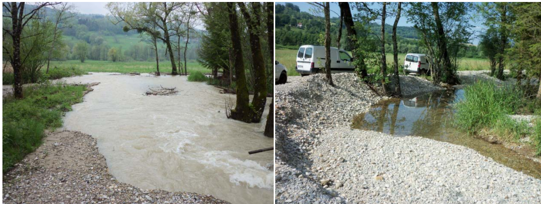
Figure 131 - Vue du coude le 28 Avril (à gauche) et en Juin (à droite, après reconstitution d'un merlon en rive gauche)
