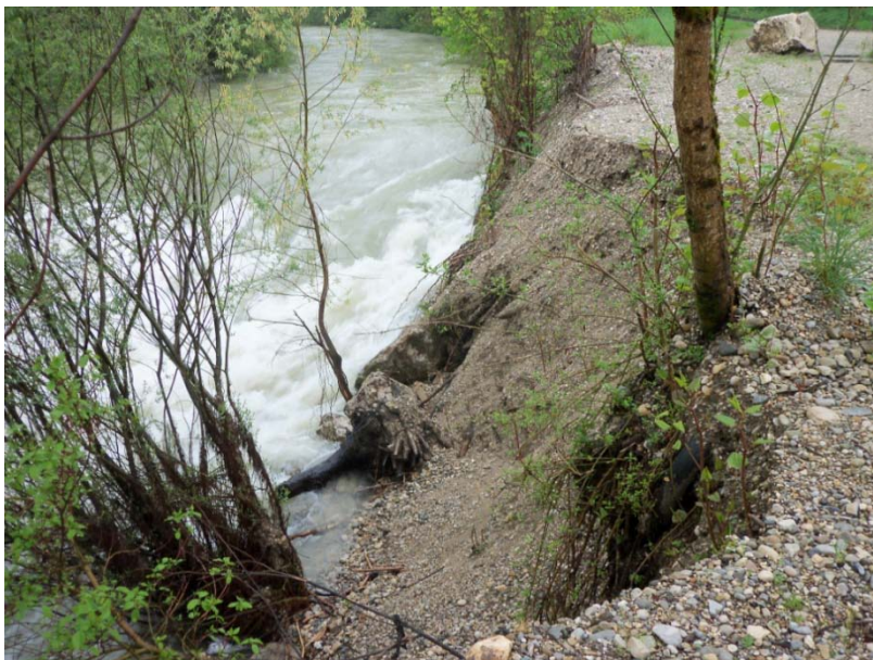
Figure 75 - Erosion de la berge de rive gauche à l'aval du seuil Jalla
