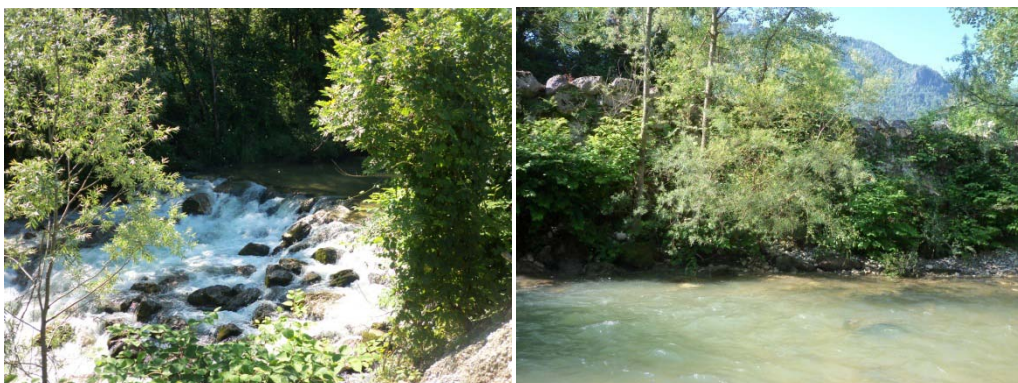
Exemple d'ouvrages susceptibles de modifier l'hydrodynamique du Guiers (seuil en travers et enrochements en berge)
