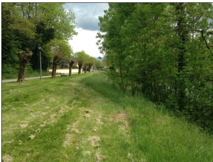
Figure 7 : Vue de la digue et de la surface à déboiser
