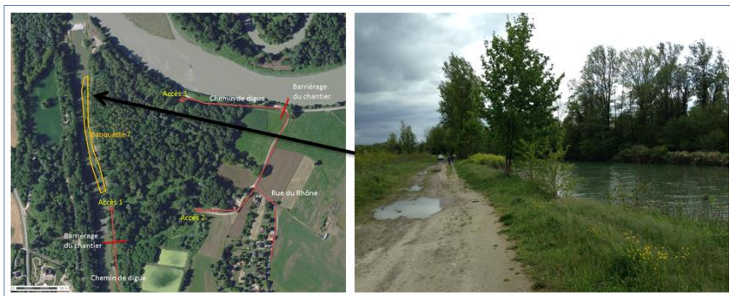
Figure 10 : Vue des accès chantier et de la berge au droit des travaux d’aménagements de la banquette 7
