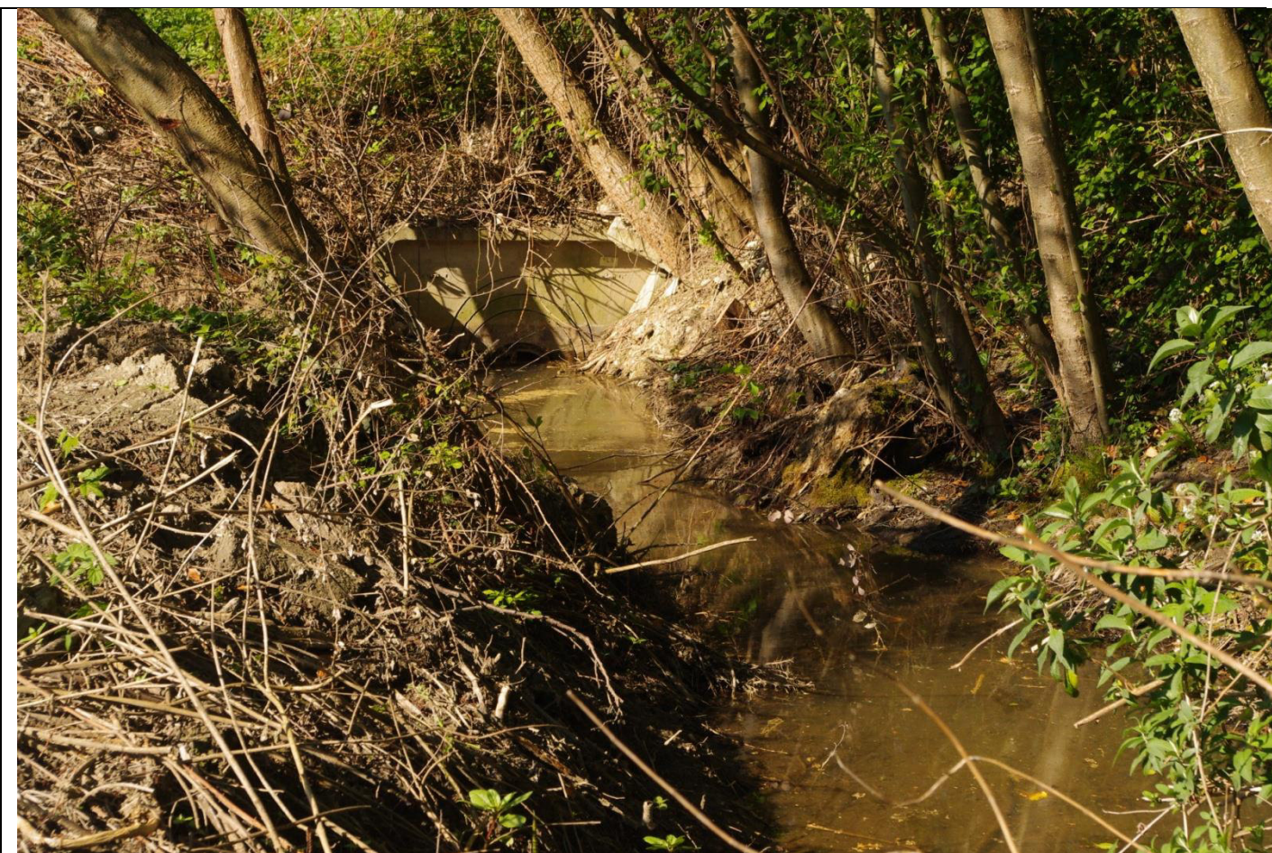
Rejet d'eau pluviale et drain sud
