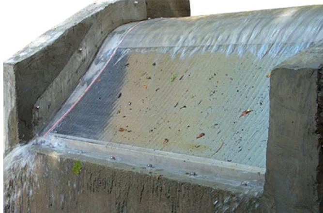
Figure 1 : Principe d'une grille Coanda.
