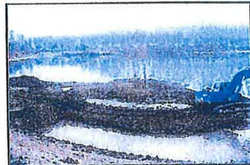
Le façonnage des berges commence dès la phase d'exploitation hors d'eau du gisement sur le pourtour de la zone d'extraction. Il consiste en un modelé sinueux afin d'obtenir un profil diversifié du plan d'eau
