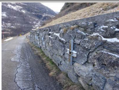
A gauche : indices de fluage de surface en amont du lotissement du Pré. Au centre : muret de soutènement ventru en amont de l'Epine, dans l'axe d'un ruisseau divaguant. A droite : indices de fluage et ancien drain en amont de l'entrée nord-ouest du Chef-lieu.
