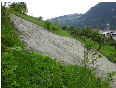
La niche d'arrachement de 2018 après remodelage du terrain, à la rupture de pente, dans le pré / verger. A droite, la reprise de chaussée en amont de la zone déstabilisée par ruissellement en 2018.
