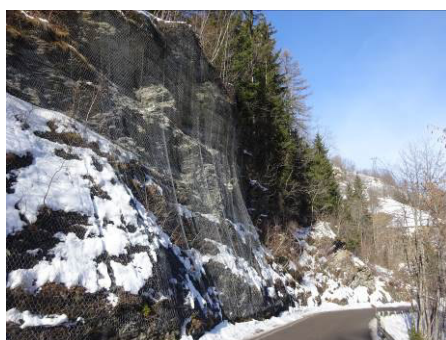
A gauche : grillages plaqués sur la route d'accès à La Gurraz. A droite : versant rocheux formé de micaschistes à l'ouest de La Gurraz.
