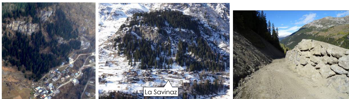
A gauche et au centre : vues générale des parois de micaschistes dominant La Savinaz (avant travaux 2018). A droite : le merlon sud, rehaussé et prolongé en 2018, protégeant efficacement le sud du hameau.
