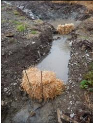
Exemple d'un système de filtration mis en place lors de terrassements -Crédit photo : KARUM
