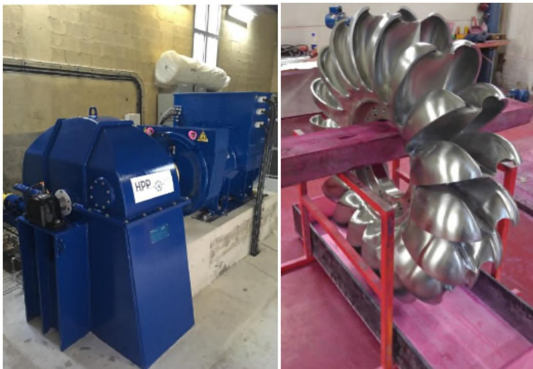
Figure 43 – Groupe à axe horizontal (source : HPP)
