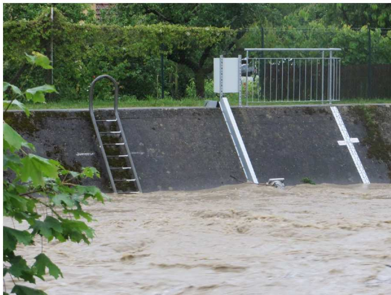
Figure 12 : Sierroz en crue vu depuis la rive droite à hauteur de la poire d'alarme et de l'échelle limnimétrique (7h15) – source : rapport de surveillance de la crue de juin 2016, EDF
