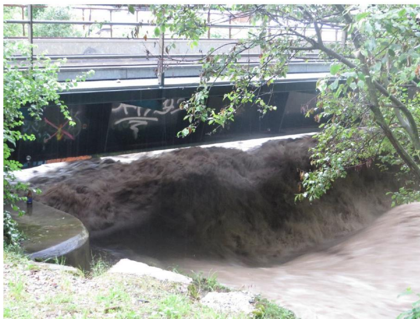
Figure 44 : Passage sous le pont SNCF vu depuis la rive gauche (7h) – source : rapport de surveillance de la crue de juin 2016, EDF
