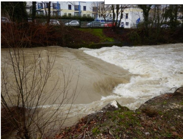
Figure 101 : aval immédiat du Pont Garibaldi - débit de 50 m3/s
