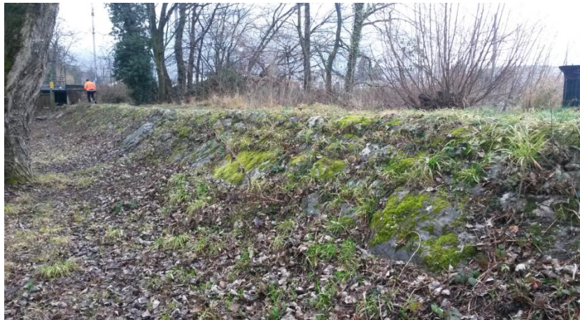
Figure 16: Perré en pierres de taille - aval rive droite. Banquette végétalisée
