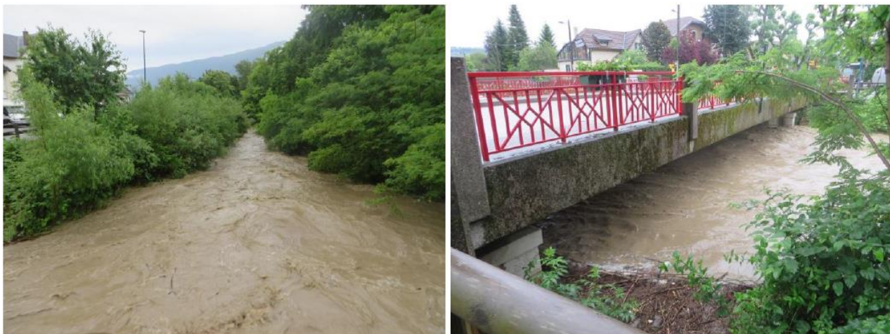
Figure 45 : Sierroz en crue vu depuis le Pont Rouge (à gauche 7h10) et hauteur d'eau sous le Pont Rouge (à droite 7h23) – source : rapport de surveillance de la crue de juin 2016, EDF
