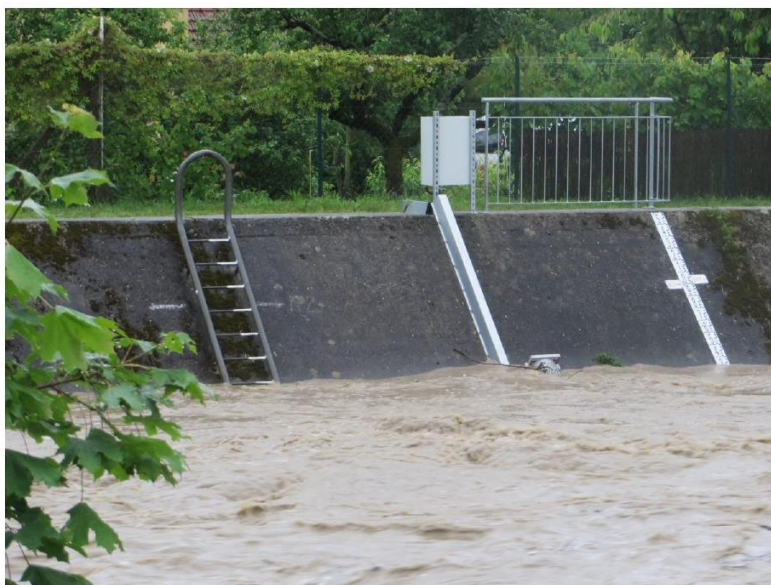
Figure 94 : Sierroz en crue vu depuis la rive droite à hauteur de la poire d'alarme et de l'échelle limnimétrique (7h15) – source : rapport de surveillance de la crue de juin 2016, EDF
