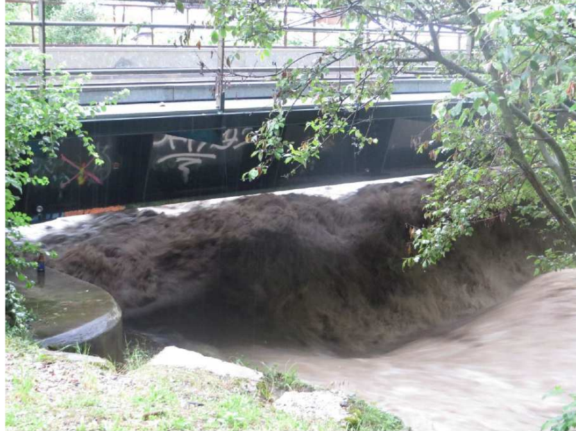
Figure 13 : Passage sous le pont SNCF vu depuis la rive gauche (7h) – source : rapport de surveillance de la crue de juin 2016, EDF
