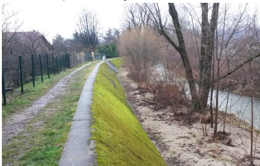
Figure 17: Parement béton - rive gauche. Atterrissement sableux sur banquette végétalisée
