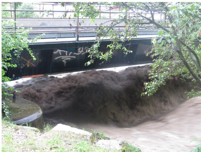
Figure 95 : Passage sous le pont SNCF vu depuis la rive gauche (7h) – source : rapport de surveillance de la crue de juin 2016, EDF
