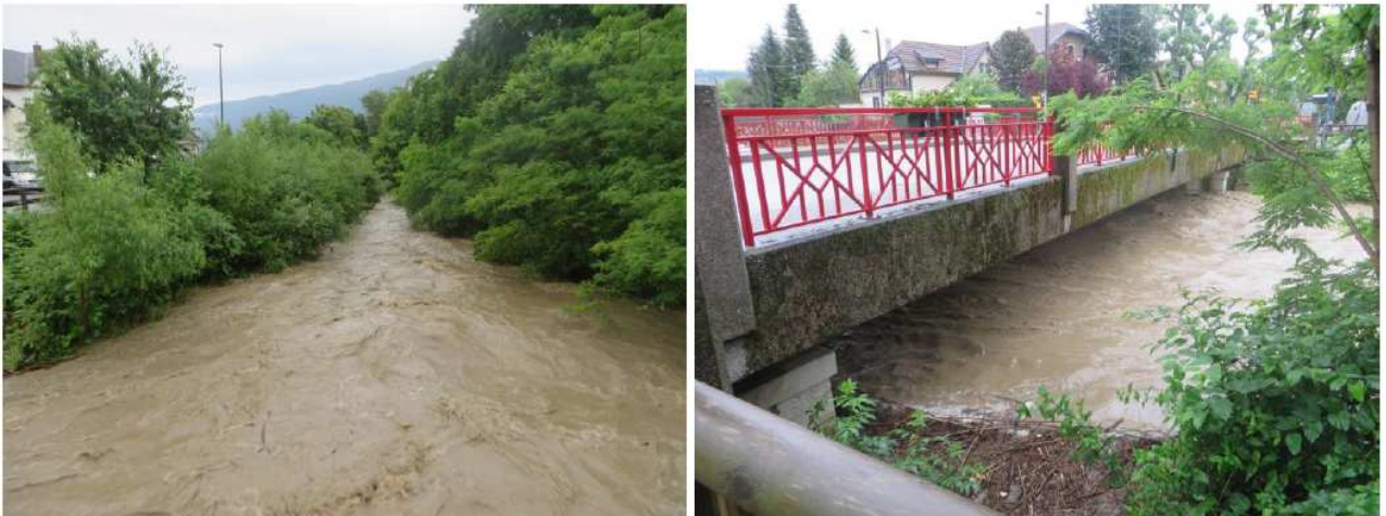
Figure 14 : Sierroz en crue vu depuis le Pont Rouge (à gauche 7h10) et hauteur d'eau sous le Pont Rouge (à droite 7h23) – source : rapport de surveillance de la crue de juin 2016, EDF
