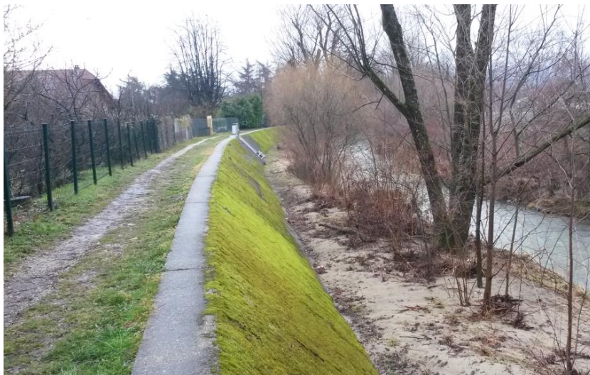
Figure 3: Parement béton - rive gauche. Atterrissement sableux sur banquette végétalisée
