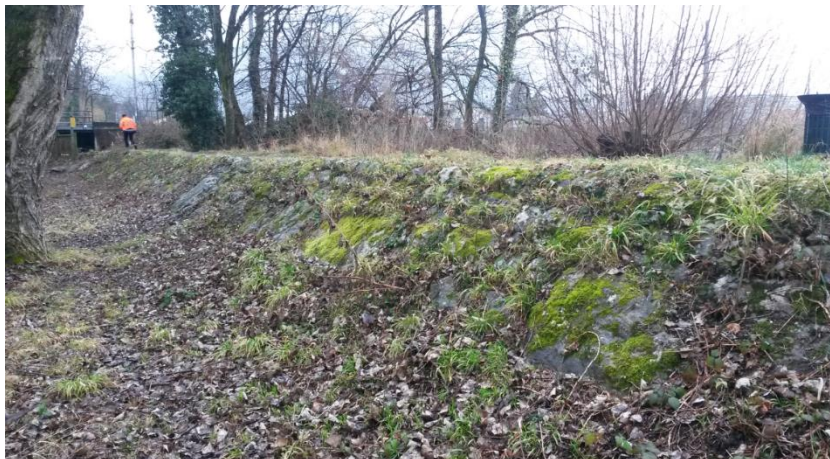
Figure 2: Perré en pierres de taille - aval rive droite. Banquette végétalisée
