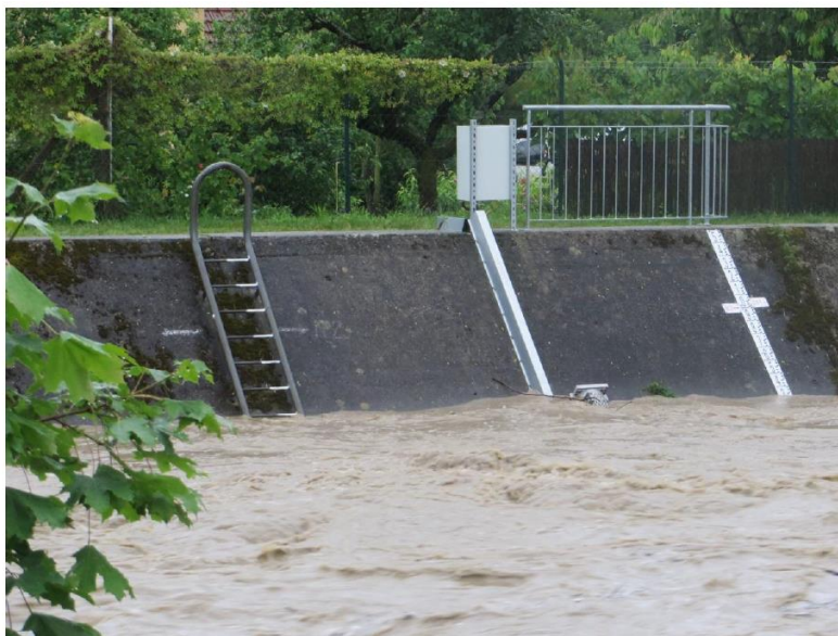
Figure 43 : Sierroz en crue vu depuis la rive droite à hauteur de la poire d'alarme et de l'échelle limnimétrique (7h15) – source : rapport de surveillance de la crue de juin 2016, EDF
