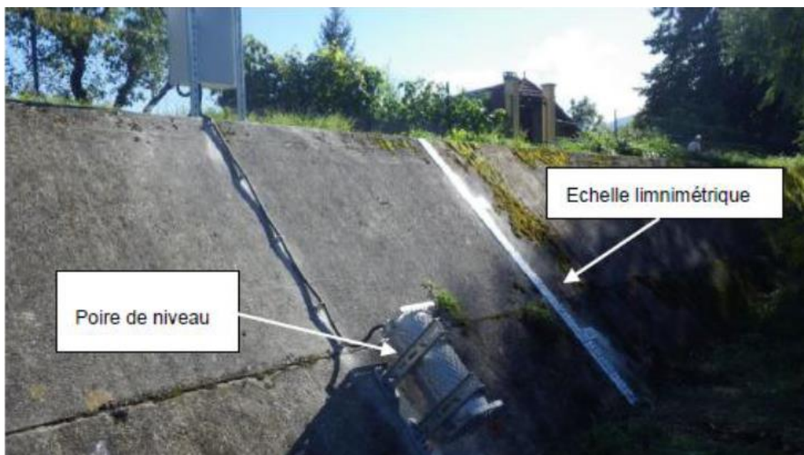
Figure 107 : Eléments du dispositif d'auscultation, situés sur le parement amont de la rive gauche (Source : Rapport EDF de surveillance suite à la crue du 16/06/2016)
