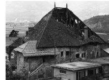
Fig. 16 Château d'Ollon (VD-CH) : Toiture de 1509-12 avant l'effondrement en 1982. (Réf. Archidotech : OLLON_01.JPG - photo Fibbi-Aeppli)
