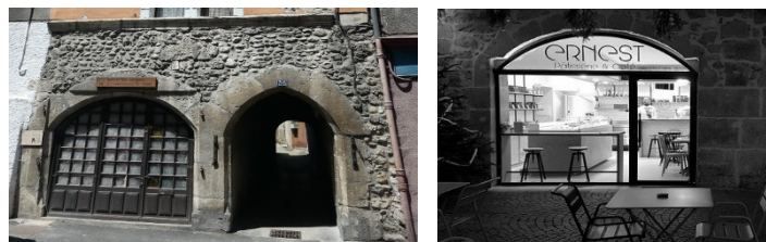
Baies en arcade fermées par menuiseries à petit bois posées en feuillure
