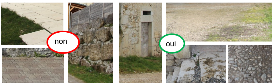
Dalles et pavés gravillonnés, enrochements
