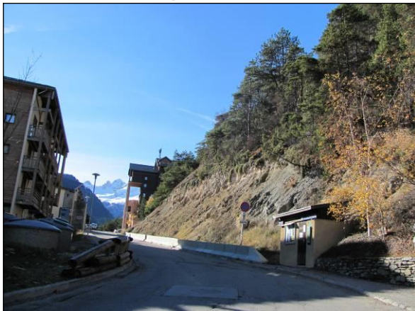
Photo 4 : Site depuis le nord est
