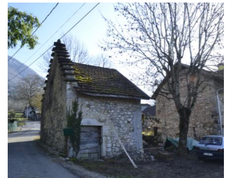
pignon « en pas de moineau »
