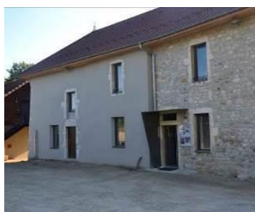
enduit fin et pierre apparente
