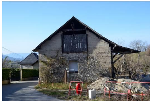
large débord sur une façade ou un pignon avec jambes de force
