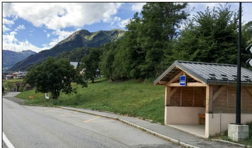
Photo 6 : Terrains objets de l'OAP depuis la route D117 au Nord-Est de la parcelle, en direction du Sud-Ouest
