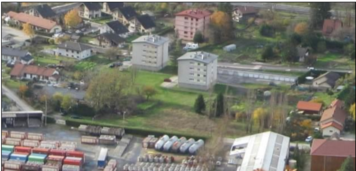
Photo 3 : Vue des terrains objets de l'OAP depuis la route de Montfort
