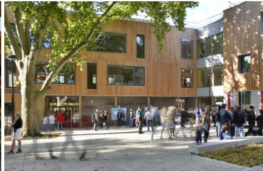
Une école compacte en R+2
