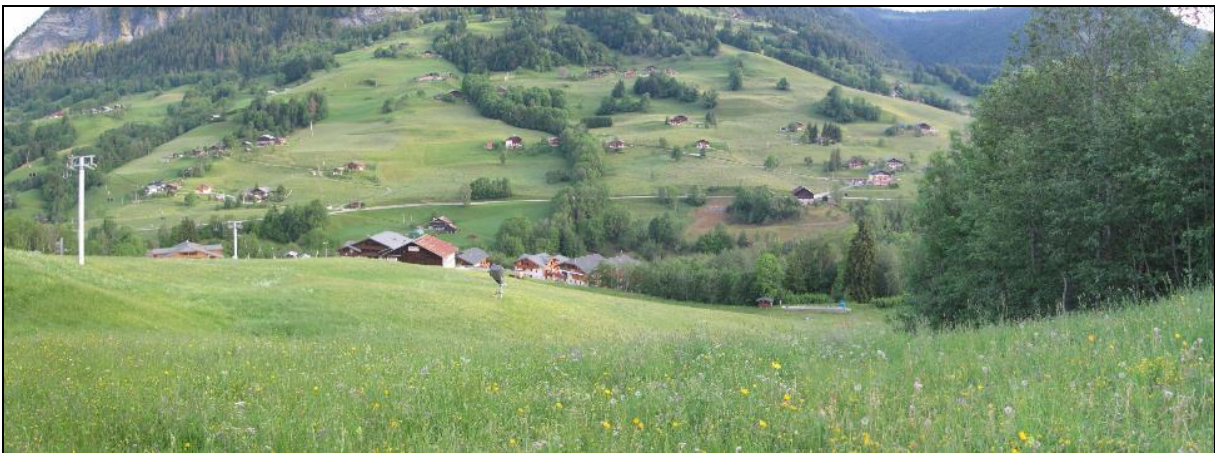
Photo 3 : Vue sur la zone depuis l'amont
