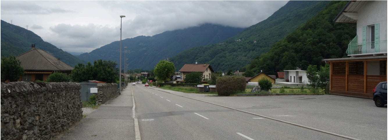
Vue de la RD 990 vers le nord : continuité de l'urbanisation entre le bourg et Arbine
