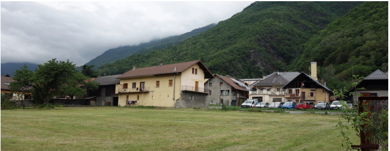
Vue vers l'amont depuis l'ouest – servitude d'accès et de façades ouvertes sur les terrains agricoles
