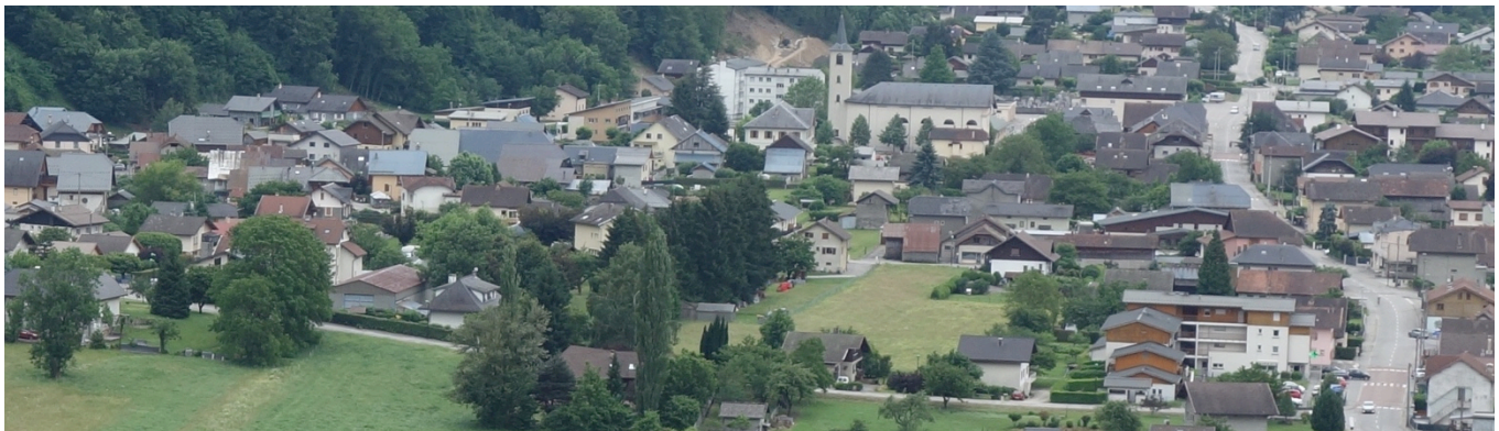
Vue vers le sud depuis le château
