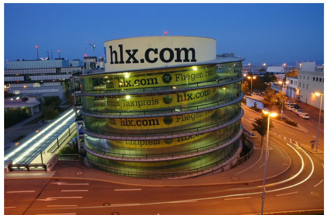
Une rampe d'accès en signal sur la place de la gare
