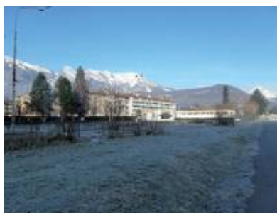
Friche de l'ancienne piscine municipale
