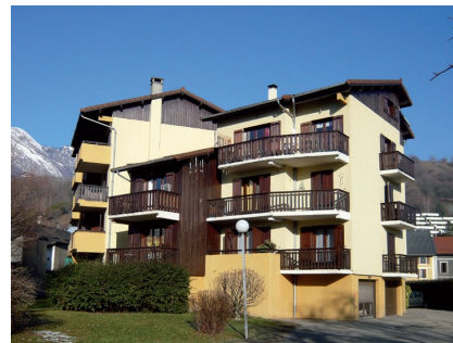
Collectif à l'intérieur de l'îlot du Noyer
